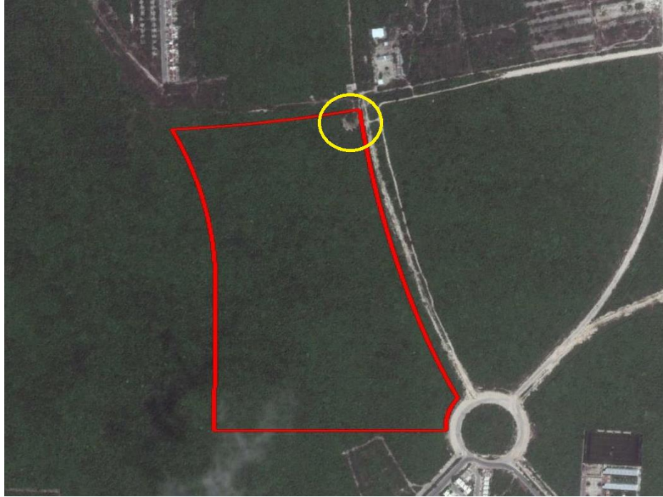
Figura No. 1 Afectación en el predio realizada por terceros.
