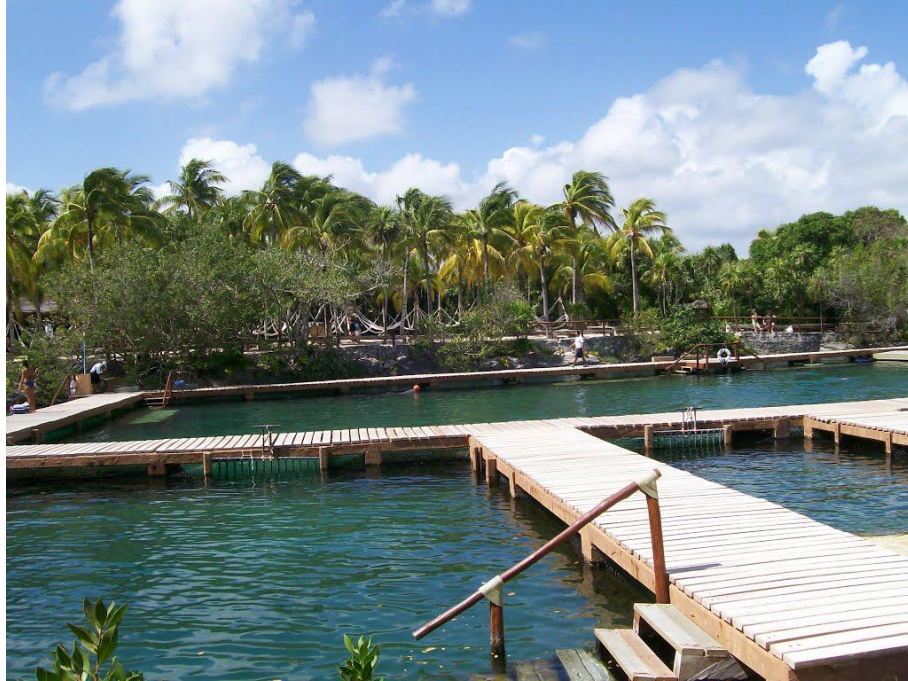
Figura IV. 33. Obras en el brazo noreste de la caleta.
