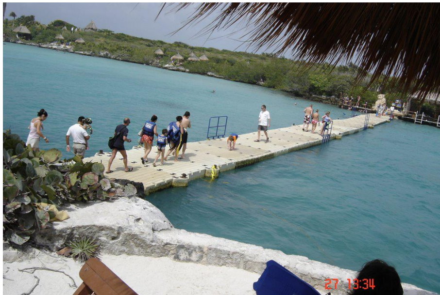
Figura IV. 32. Obras en la boca de la caleta.
