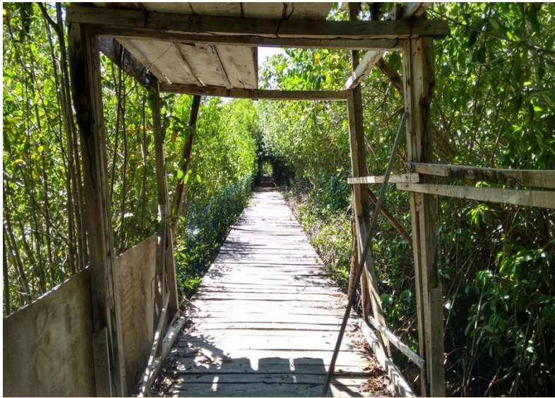
Figura IV-66. Puente de acceso piloteado.
