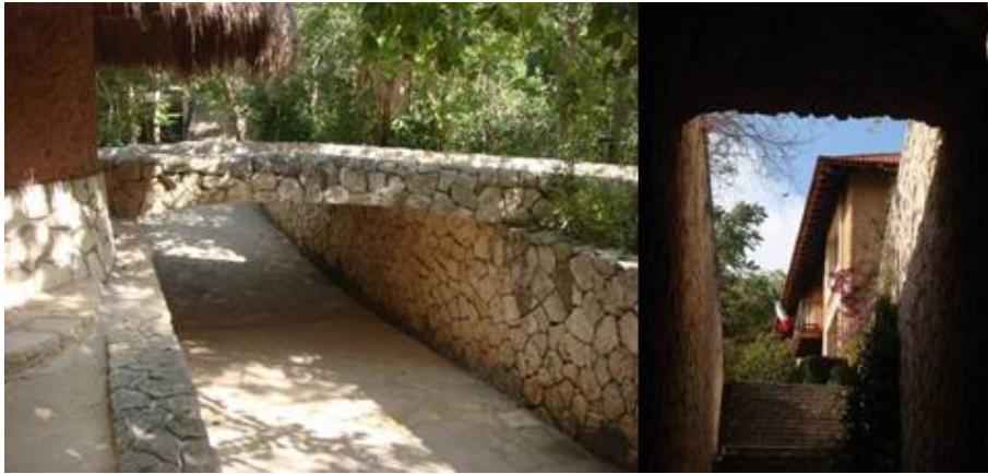
Figura II.5. Túneles de comunicación y servicios.
