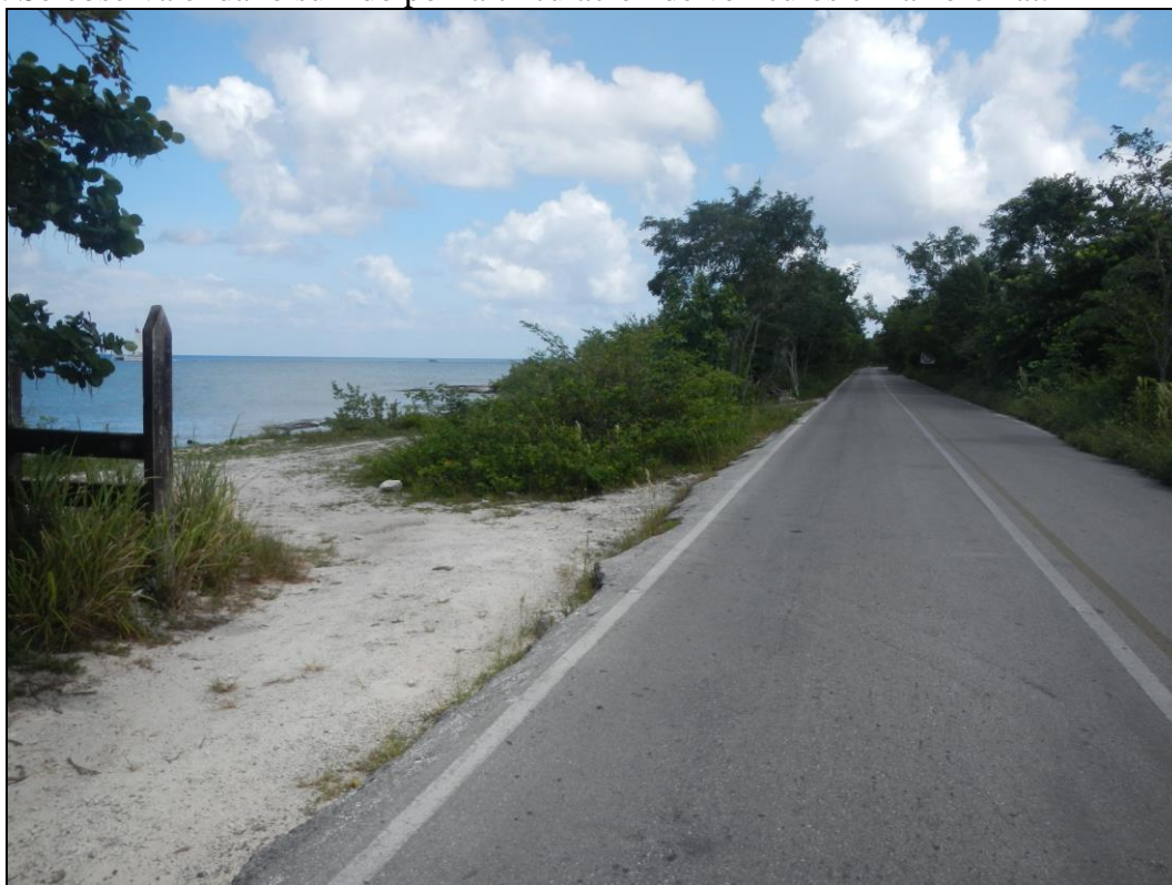
Imagen del año 2016 tomada con cámara digital. Se observa la similitud de la imagen del Googleearth del año 2014. Se aprecia el marcado deterioro del suelo que ha perdido su capa orgánica y la presencia de vegetación secundaria.
