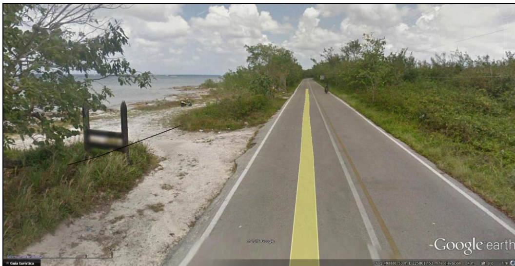
Imagen obtenida del Street View del Googleearth del año 2014. La orientación es de Sur a Norte. Se observa el daño sufrido por la circulación de vehículos en la zofemat.
