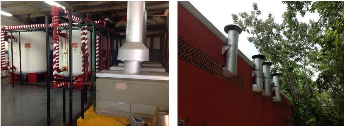
*Figura 37. A la izquierda se aprecian los calentadores o calentadores, así como los tanques de almacenamiento de agua caliente, a la derecha los ductos que liberan las emisiones al ambiente.*
