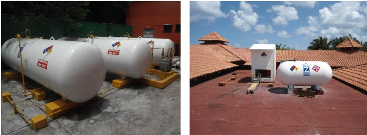
Figura 18. La empresa cuenta con cinco tanques de almacenamiento de gas L.P., tres de 5,000 L de capacidad ubicados en la zona lateral del edificio principal; así como un tanque de gas L.P. de 1,600 L ubicado sobre firme a nivel de piso al lado del camino de acceso sur, junto almacén de Stewart; y uno más ubicado en la azotea del Club de Playa en la zona suroeste del hotel con 1,600 L de capacidad.
