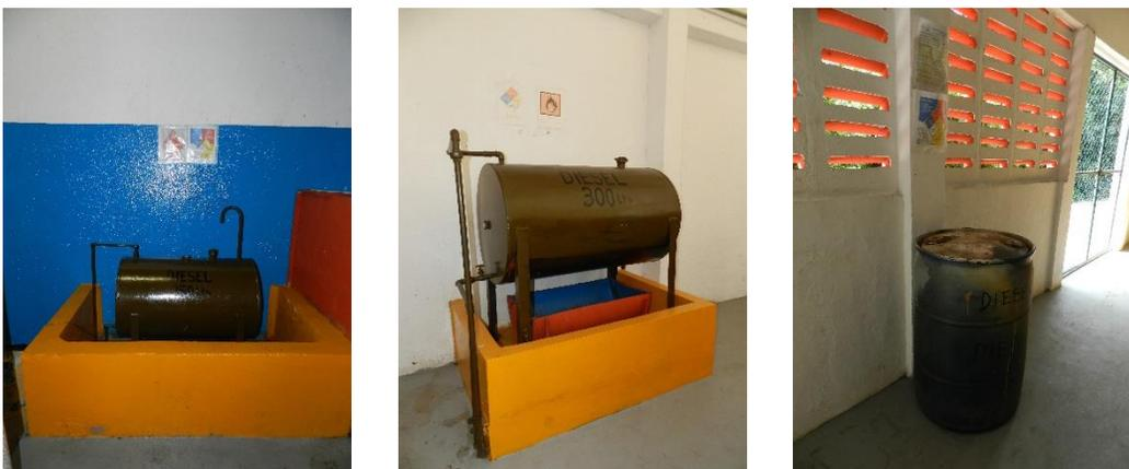
Figura 27. Se muestran tanques de diésel. Los almacenamientos cumplen con las normas de seguridad aplicables en la materia. Fotos L. Guillermo, 2016.
