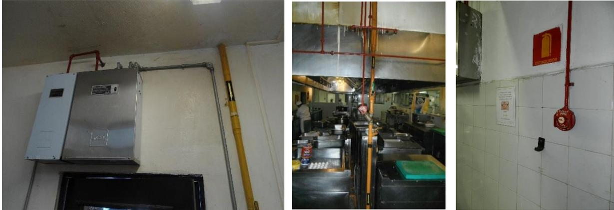
Figura 21. Las instalaciones de las cocinas principales incluyen sistemas ANSUL para la extinción automatizada de fuego y corte de gas en caso de presentarse un incendio. Fotos: L. Guillermo, 2014.
