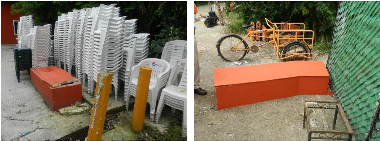
*Figura 38. Los pozos de rechazo están encofrados y protegidos para prevenir la intrusión de elementos contaminantes al acuífero.*
