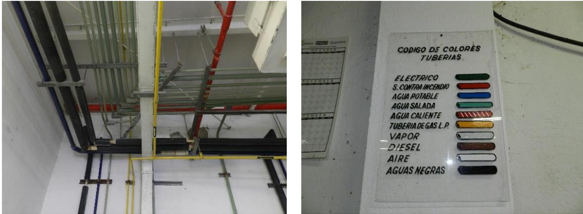
Figura 30. Las instalaciones cumplen con lo señalización de ductos conforme a la Norma NOM-026-STPS-2008.
