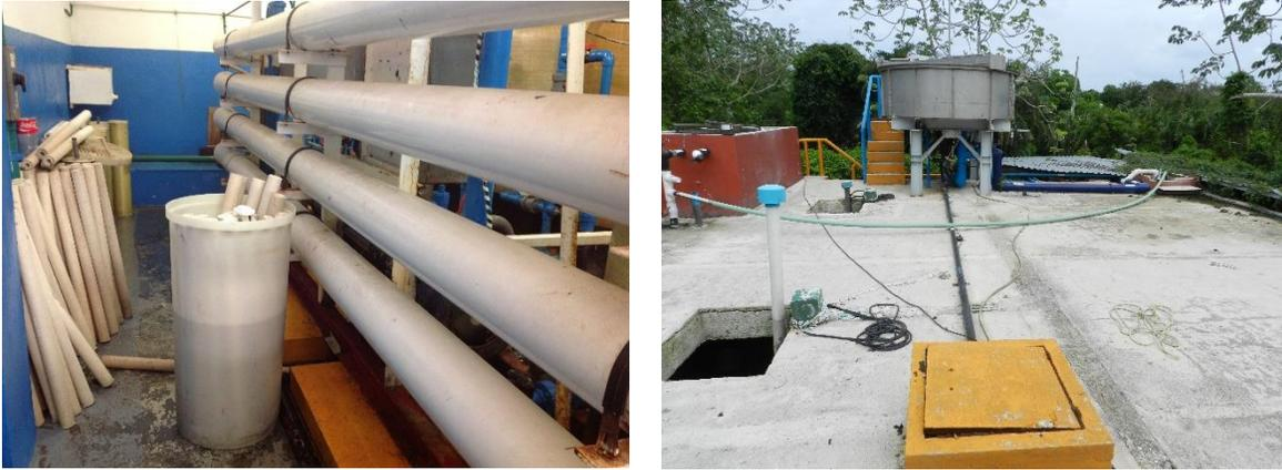
Figura 14. Se muestra la planta de osmosis inversa que se emplea en el hotel y la planta de tratamiento de aguas residuales instalada.
