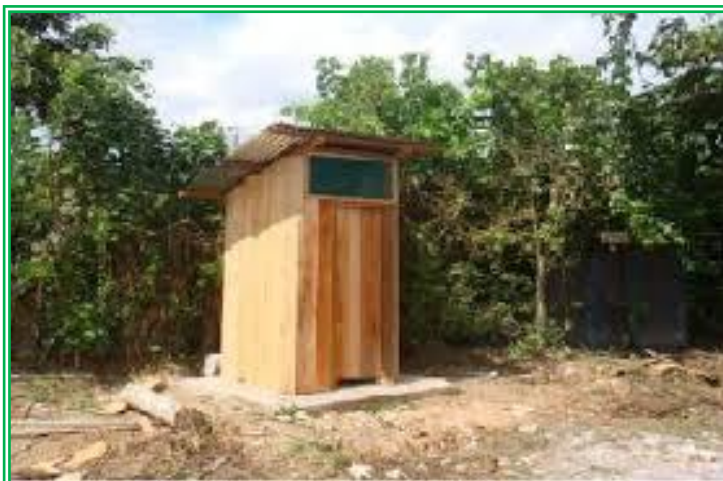
Características del Sanitario de Campo que será empleado en esta etapa.
