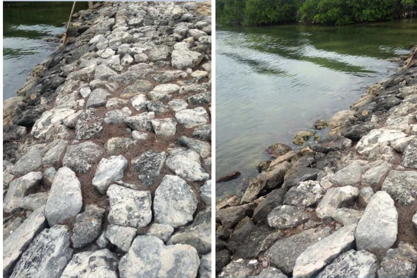
Se observa en las imágenes el piedraplen que implica la contención del área rellenada. El piedraplen extiende una cara húmeda o sumergida sobre el suelo lagunar.
