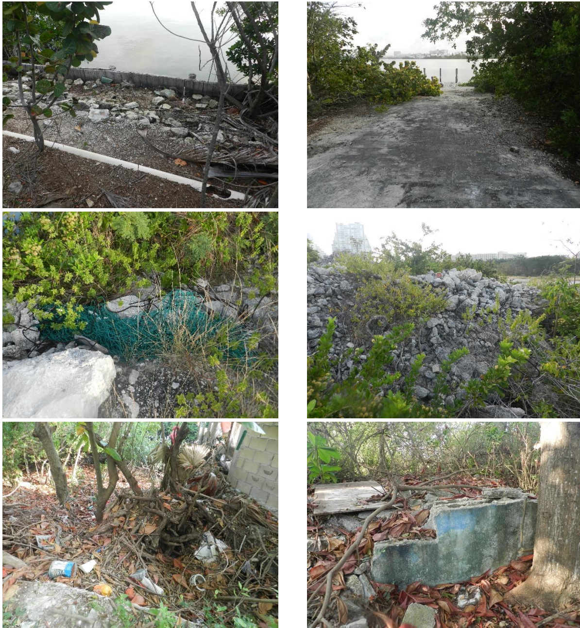
Figura 61. Condición actual de los bordes del proyecto y su área adyacente inmediata.
