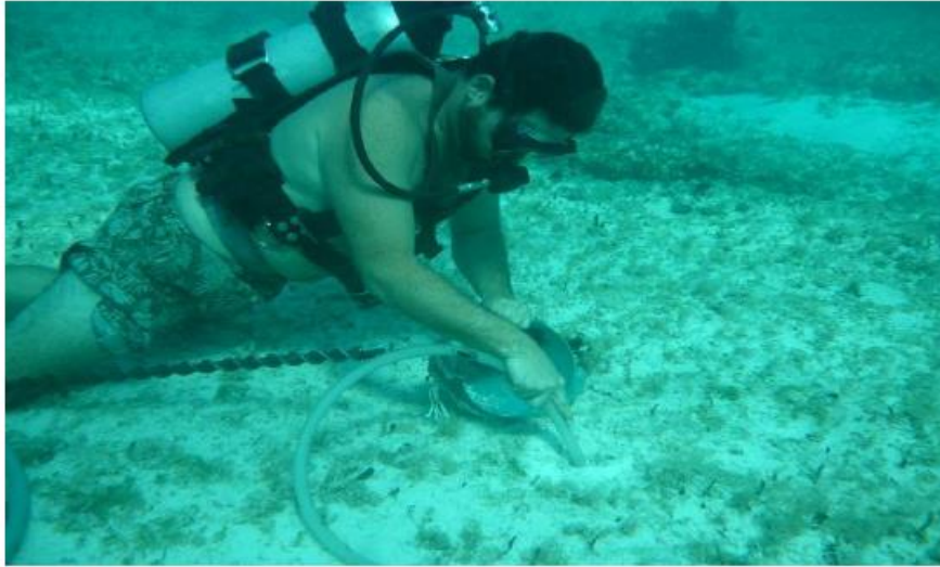
Limpieza de barreno por medio de sistema de bombeo anti-sedimentos.
