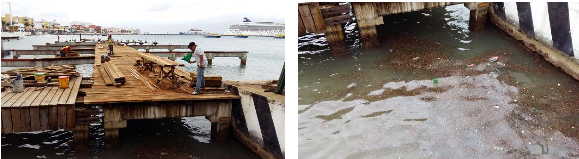
Figura 5.5. Potencial dispersión de residuos líquidos y sólidos en el área marina por las corrientes en caso de no contar con mallas antidispersión de sedimentos.
