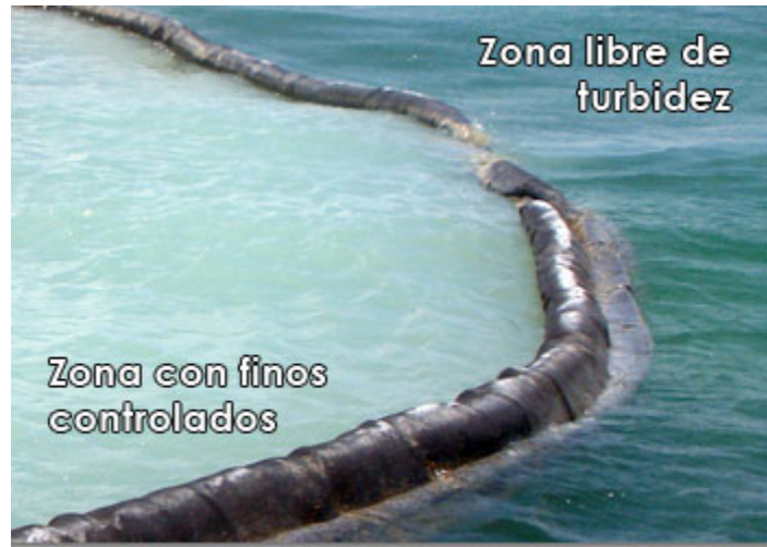
Figura 5.6. Funcionamiento de mallas antidispersión de sedimentos.
