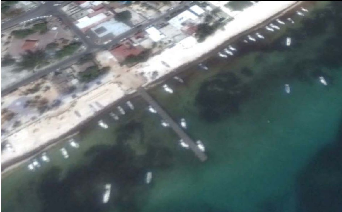
Figura 4.21. Panorámica del sitio del proyecto en donde se puede observar la escases de infraestructura portuaria y el acomodo de todas las embarcaciones menores a lo largo de la playa de la localidad de Puerto Morelos, lo que genera que no se tenga un control sobre su operación y demerita la calidad ambiental y turística de la zona costera de la localidad.
