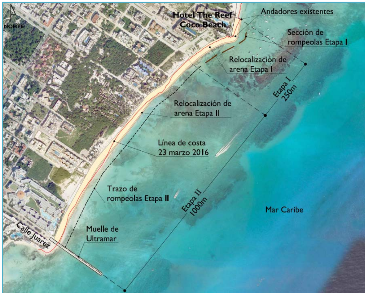
Figura VII_4. Obras del proyecto
