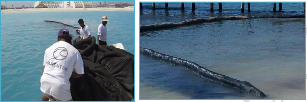
Figura II_26. Colocación y funcionamiento de malla antidispersión, en proyectos similares.
