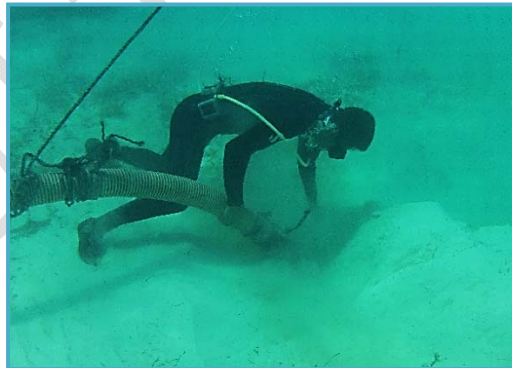
Figura II_29. Colocación de tuberías y mangueras para el transporte de arena.
