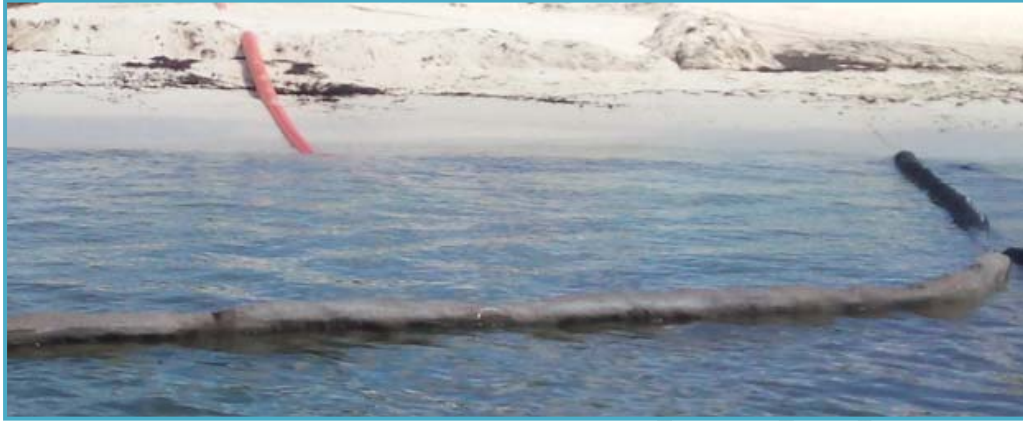
Figura II_28. Descarga de arena sobre la playa.
