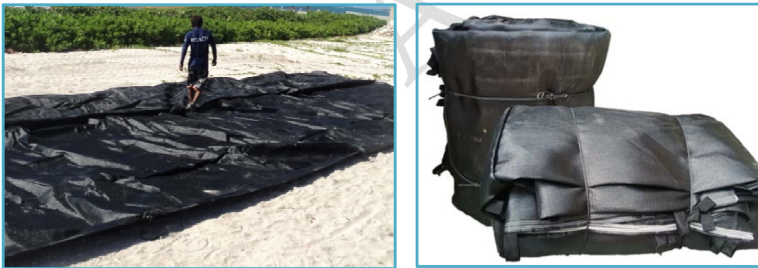
Figura II_ 21. Tubos de geotextil para el desplante de rompeolas.
