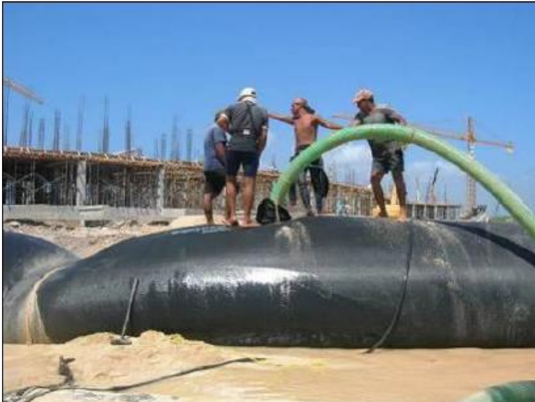
Figura 2. 24. Llenado del geocilindro con el tubería flexible de 6 pulgadas.
