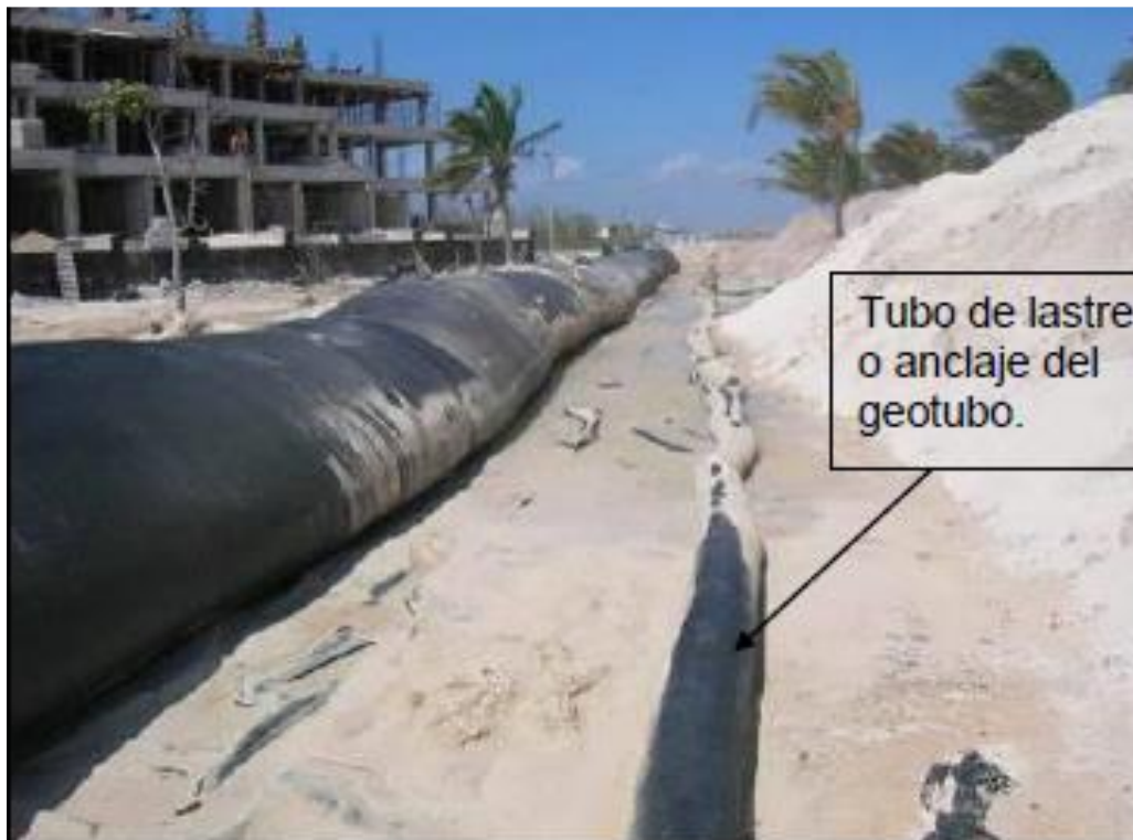
Figura 2. 26. Ya alcanzada la altura de diseño se llena el tubo de lastre localizado al extremo del tapete antisocavación.
