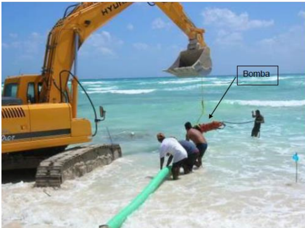
Figura 2. 15. Otra bomba sumergible es colocada en el mar para bombear agua hacia la tarquina y poder hacer la mezcla agua-arena.
