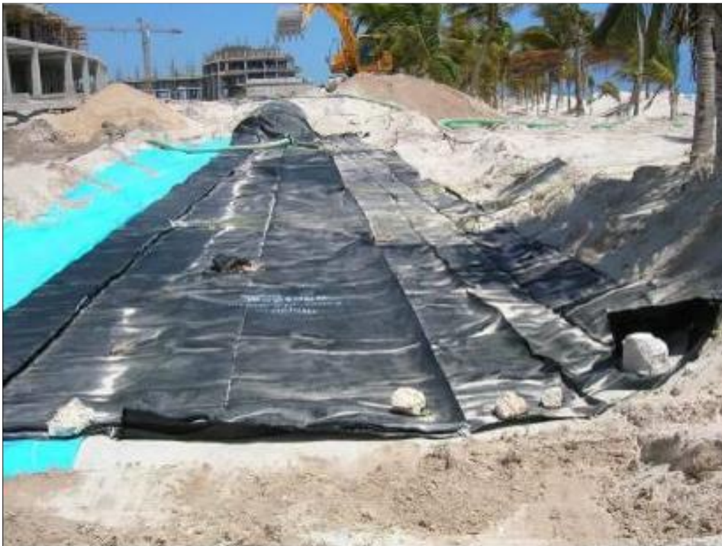
Figura 2. 22. Extendido, amarre y preparación del geocilindro.
