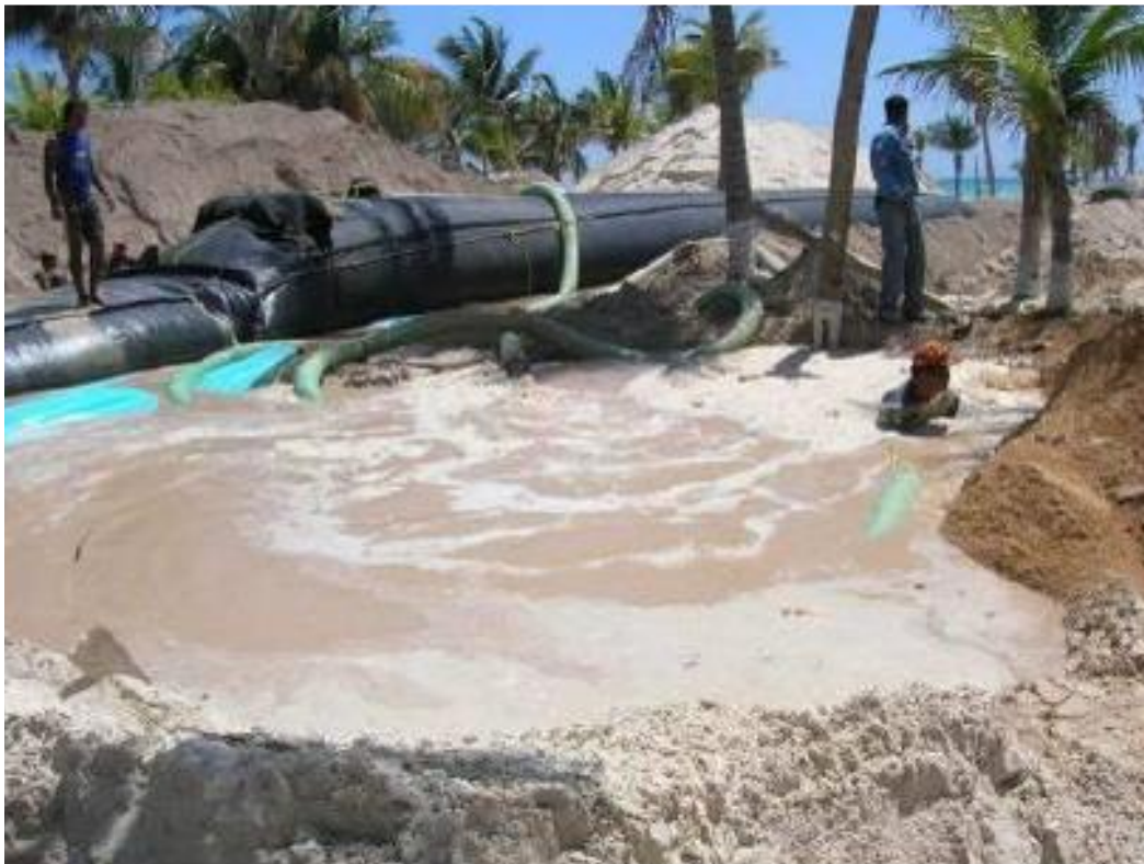
Figura 2. 23. Bombeo de la mezcla agua-arena con la bomba sumergida en la tarquina.
