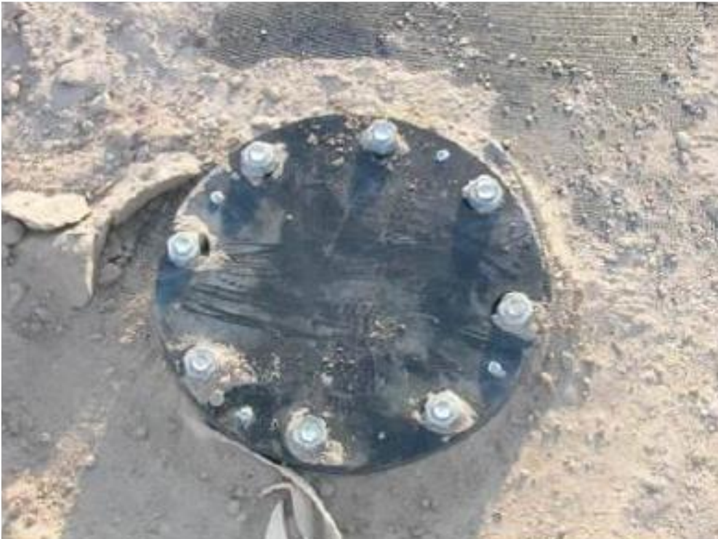
Figura 2. 25. Cerrado de los puertos de llenado con tapa atornillada.
