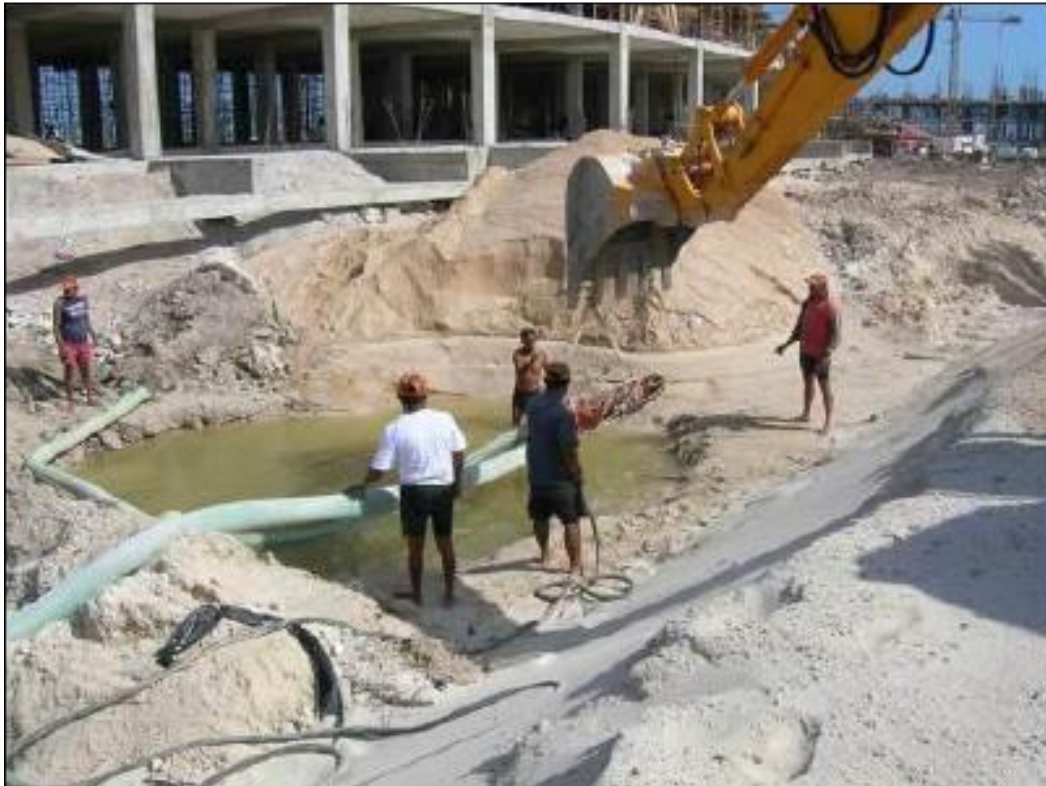
Figura 2. 14. La arena se introduce a la tarquina en cantidades apropiadas con el uso de un BOBCAT.
