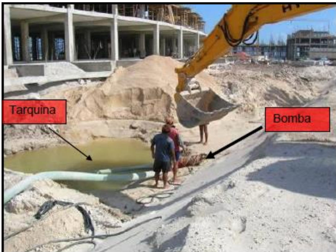
Figura 2. 12. La imagen muestra una tarquina con arena depositada a su alrededor, la tubería usada para el relleno de los geocilindros y la bomba que será colocada dentro de la tarquina. Dicho procedimiento llevado a cabo dentro del complejo hotelero, actualmente en constricción.
