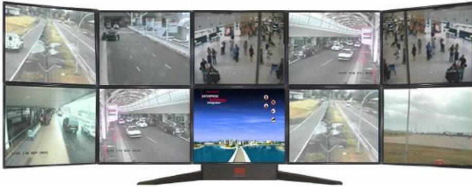
Imagen II-23. Circuito cerrado de televisión para el control de la seguridad del desarrollo.
