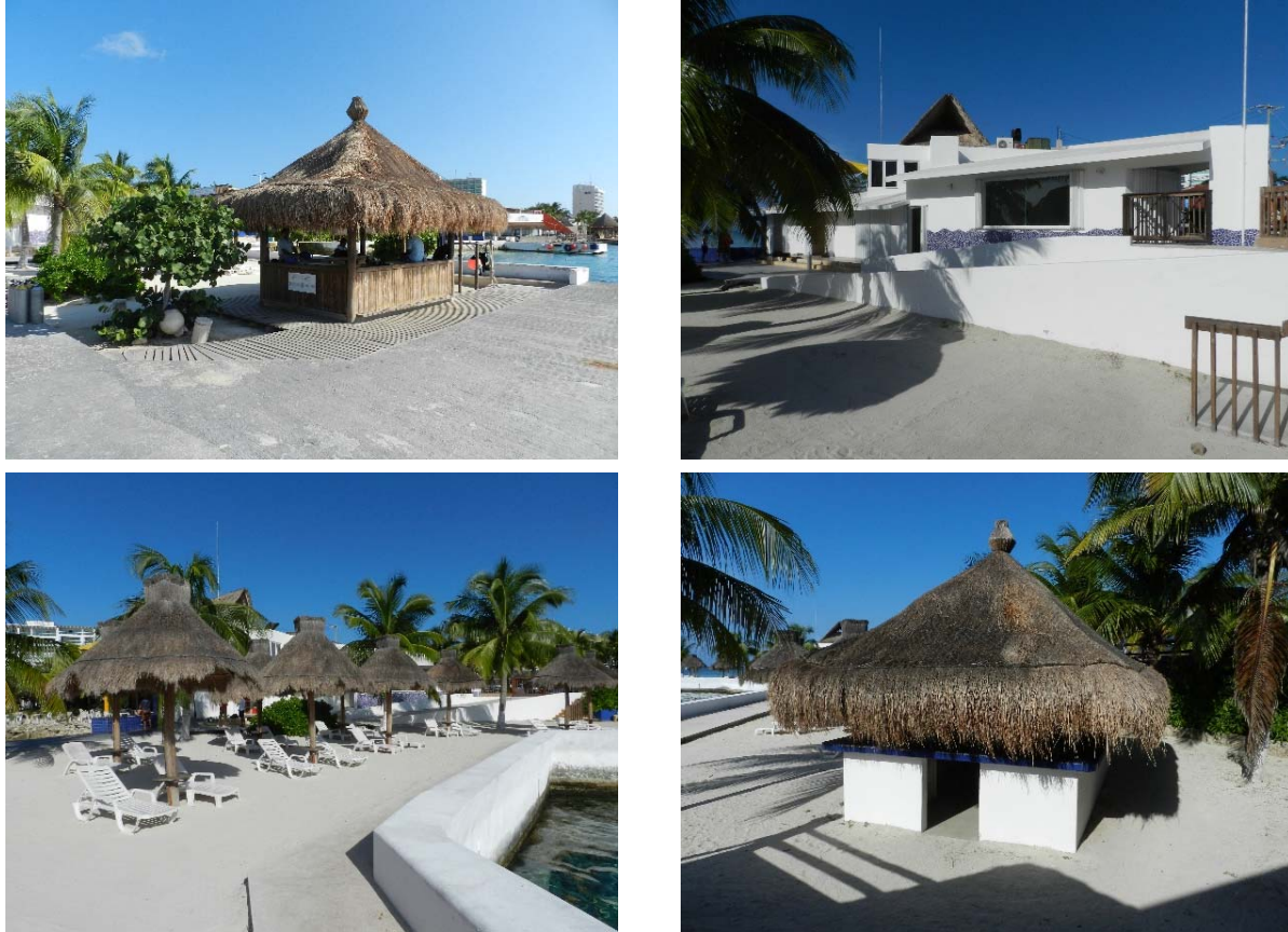
Figura 9. Se observa en estas imágenes algunas de las obras que conforman el Club de Playa del hotel Casa del Mar en la actualidad. De arriba abajo y de izquierda a derecha: palapa rectangular con barra y piso de madera, localizada en la parte norte; rampa de concreto armado para acceder al muelle localizada en la parte norte y edificio de dos plantas en la parte norte; palapas con postes de madera (sombrillas); snack bar de forma rectangular localizado en la parte sur, con piso de cemento, techo de zacate, circularada con muros de block y barra de concreto; edificio de una planta localizado en la parte sur. Fotos: L. Guillermo, 2015.
