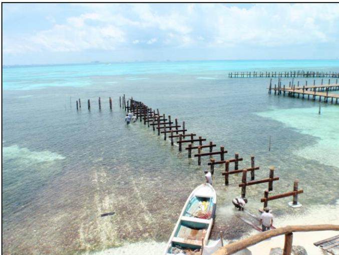
Esta es una imagen ejemplo, de la construcción del embarcadero, se observa que los pilotes ya fueron hincados. Como se observa la estructura del embarcadero es a base de madera, alineada y realizada con medios manuales sin ayuda de maquinaria pesada, únicamente con la motobomba para la perforación del suelo.
