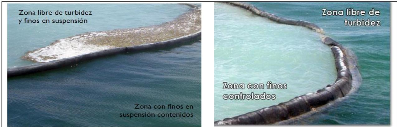
También es importante mencionar que la colocación de la malla geotextil antidispersante tiene una función importante en disminuir la dispersión de los sedimentos en la zona y evita que sean transportados a otras áreas.
