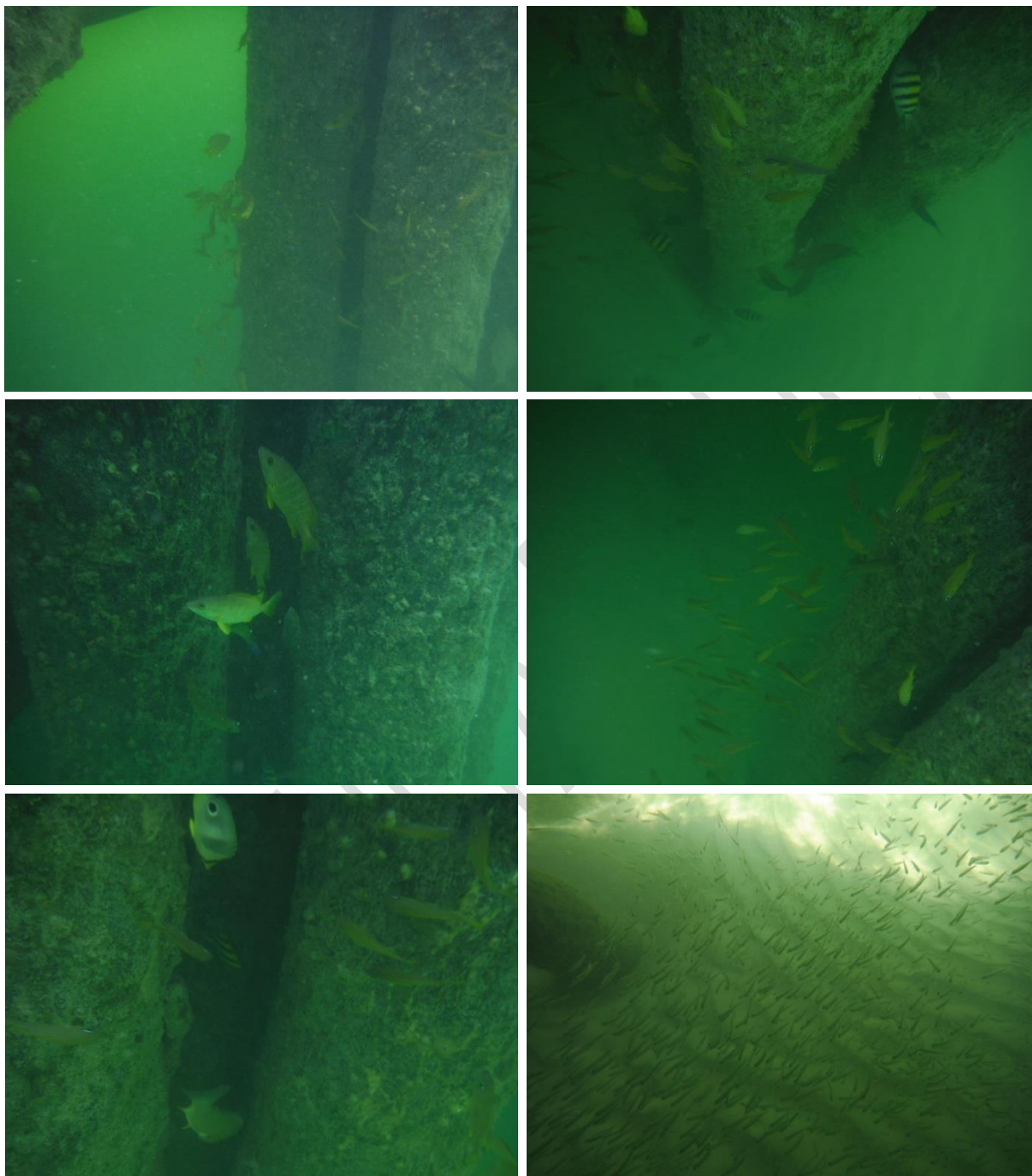
En la imagen se puede observar que los pilotes fungen como refugio para peces.
