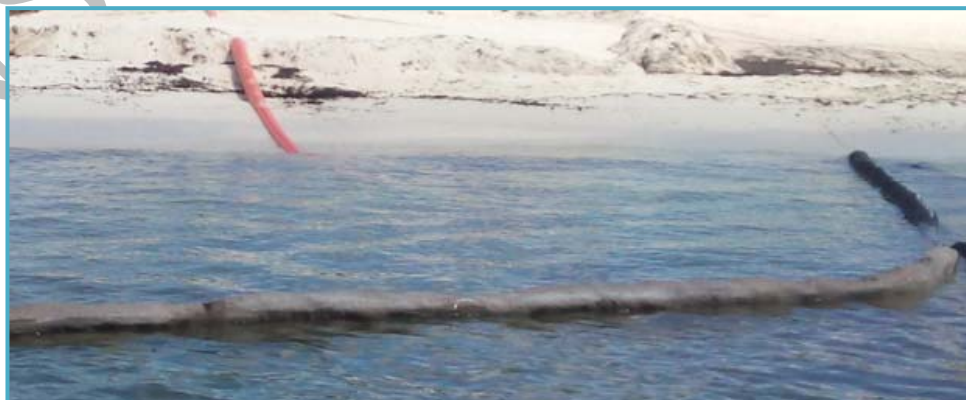
Figura II_ 13. Descarga de arena sobre la playa.
