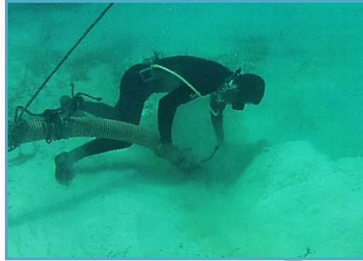
Figura II_ 14. Colocación de tuberías y mangueras para el transporte de arena.
