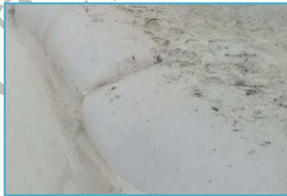
Figura II_ 8. Ejemplo de elemento de geotextil temporal de apoyo.
