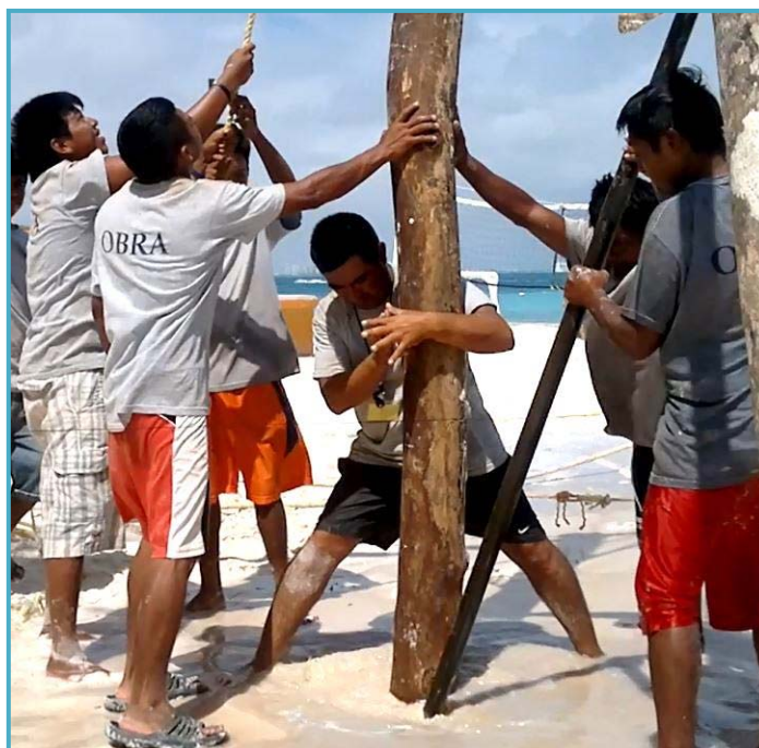
Figura II_ 18. Proceso de chifoneo y colocación de los pilotes de soporte.
