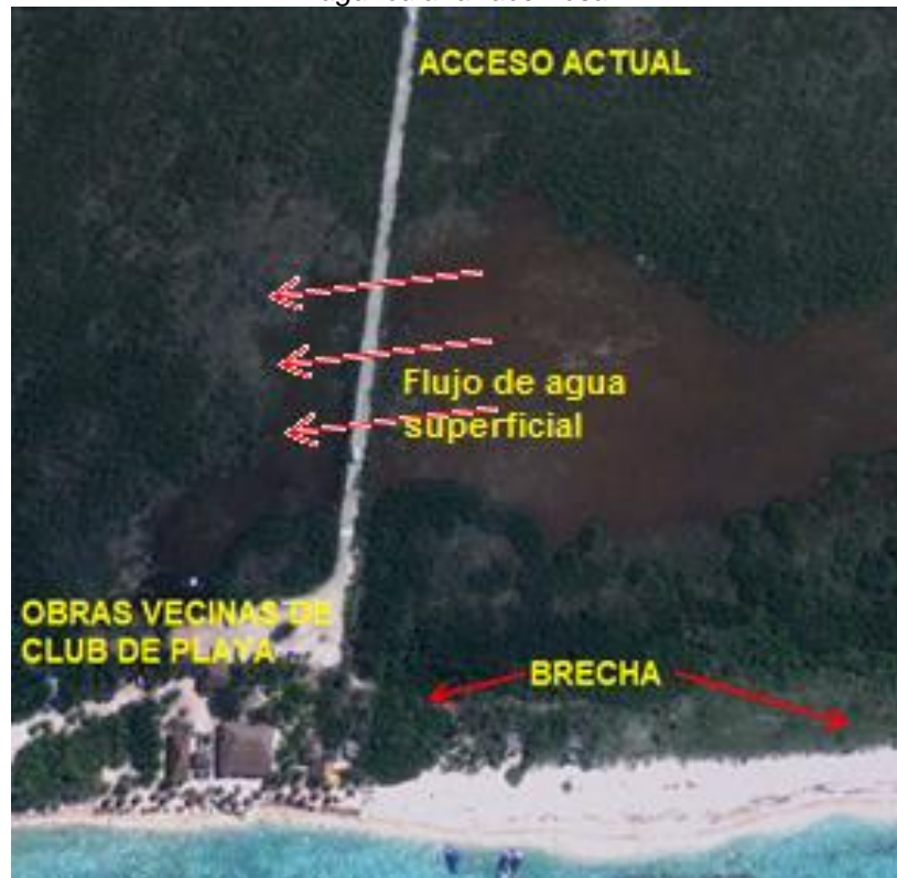
Paso de agua actual en camino de PREDIO CONTIGUO
