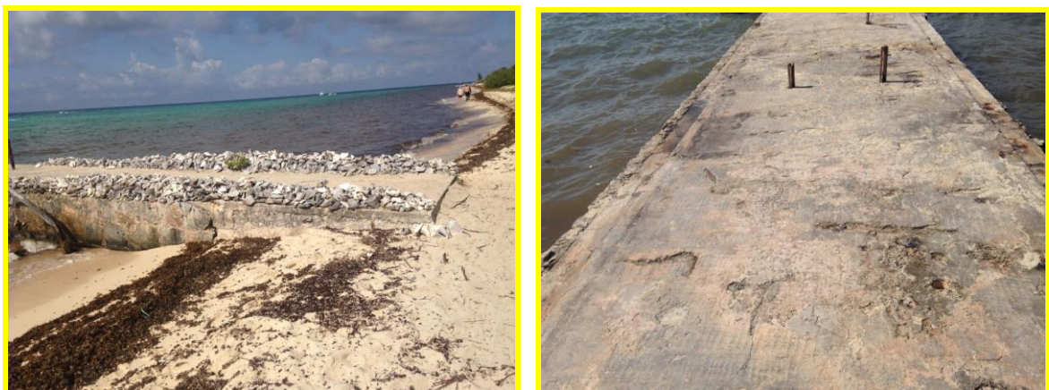
Condiciones actuales del muelle que será rehabilitado y cubierto de madera.
