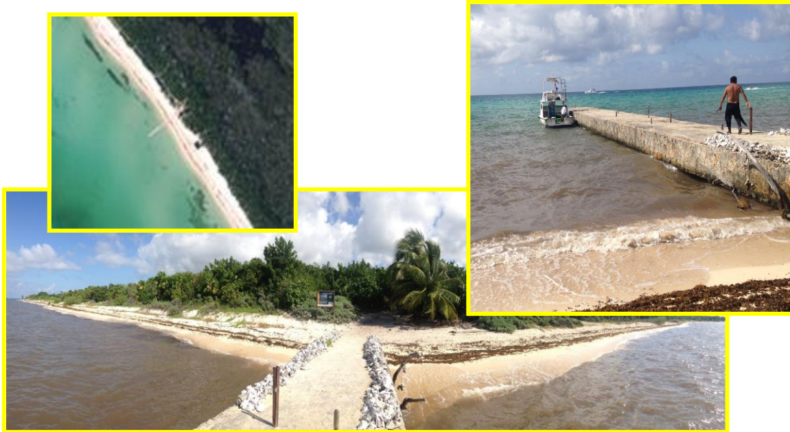
Condiciones actuales del muelle que será rehabilitado y cubierto de madera
