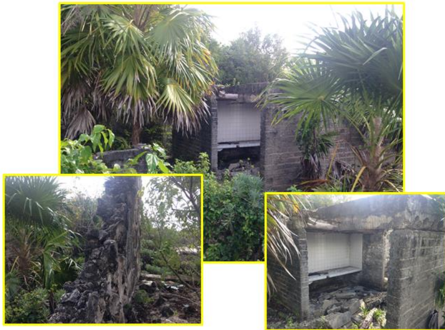
Las ruinas de obra civil. Vegetación arbustiva y Thrinax radiata
