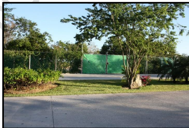
Colindancia Oeste, paseo Grand Coral y entrada al predio.
