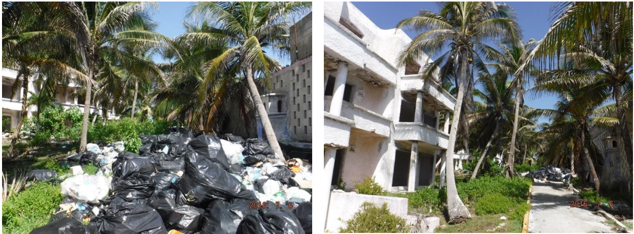
Figura 4. 21. Condición del predio en el lindero norte.
