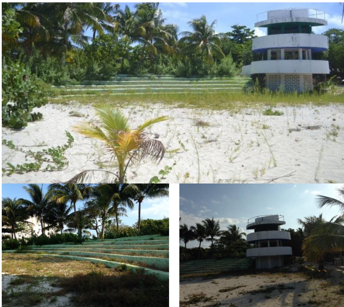
Figura 48. Obras presentes en el predio.
