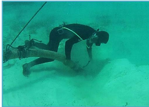
Figura II\_27. Colocación de tuberías y mangueras para el transporte de arena.
