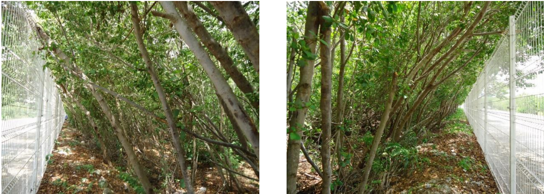
Figura No. 35 Malla metálica (cerca) que delimita el manglar de la vialidad pavimentada.
