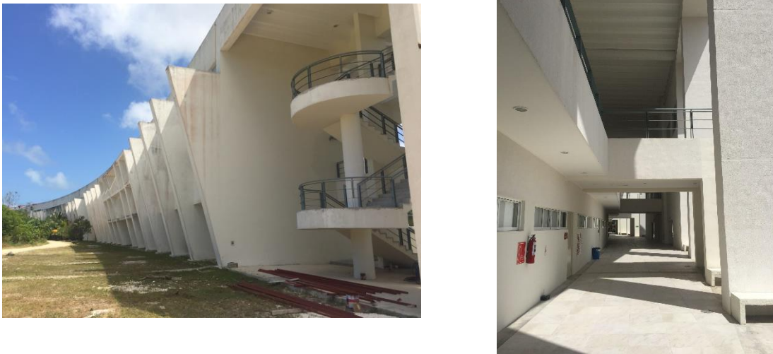
Figura No. 9 Vista posterior y vista del pasillo interno en edificio de etapas 5, 6, y 7.
