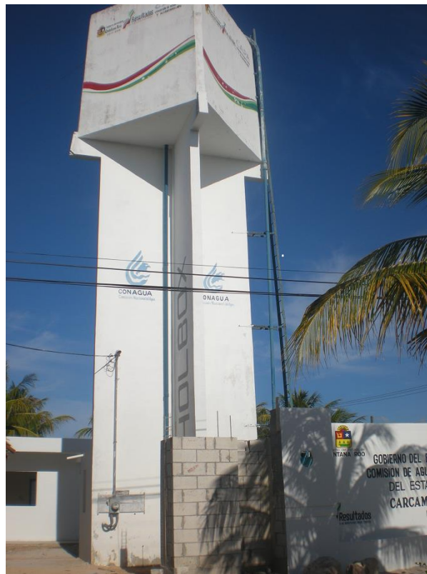
Fig. 23.- Cárcamo de agua potable CAPA Isla Holbox, Quintana Roo
