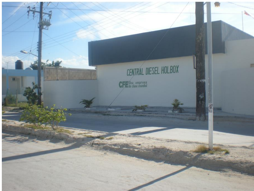
Fig. 22.- Planta generadora de energía eléctrica CFE Isla Holbox.
