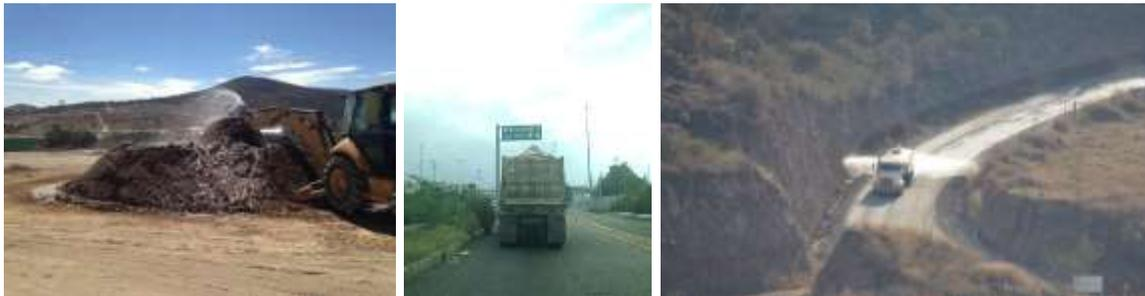
**Figura VI.4. Riegos de apoyo para evitar la volatilización de partículas producto de las actividades de construcción del proyecto.**
