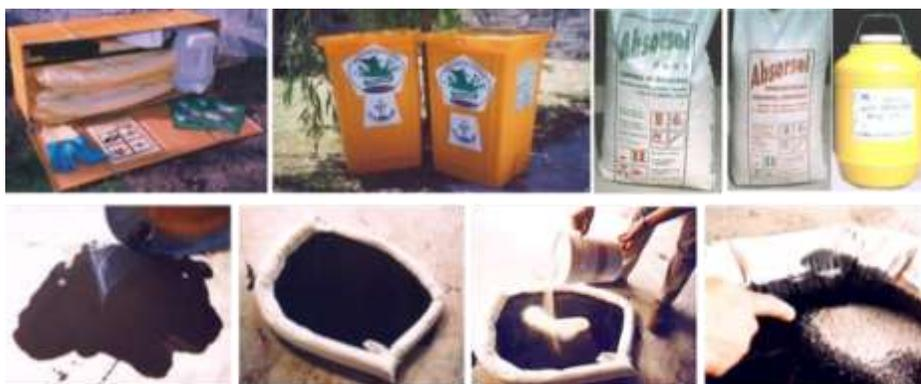
**Figura VI.9. Sistemas para la retención de hidrocarburos, pinturas y/o aceites que pudieran ser derramados de forma accidental en sitio de obra. En la fila inferior se puede apreciar el proceso de retención y absorción del derrame.**
