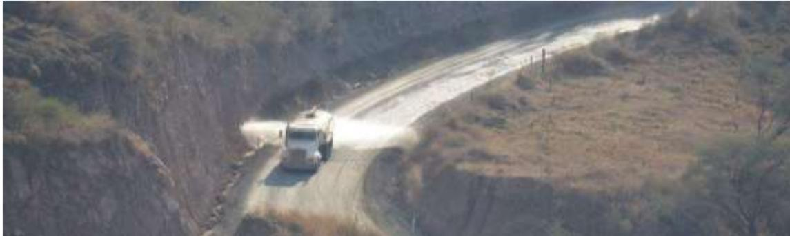
**Figura II.14. Utilización de agua cruda para procesos de aspersión y riego, esta actividad reducirá el levantamiento de polvos productos del movimiento de tierras. (Imágenes tomadas del Proyecto Zapotillo, CONAGUA, 2010).**
