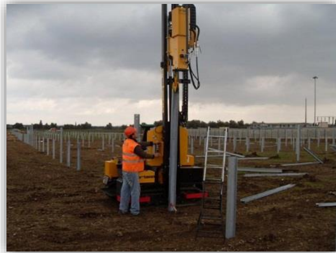
Fotografía II.2. Ejemplificación de maquinaria utilizada para el hincado de perfiles en un parque solar 1 .
