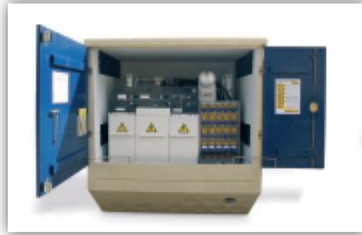
Figura II.10. Edificios prefabricados de hormigón (maniobra exterior) 2 .
