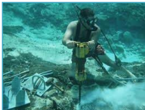
Figura II_ 48.- Ejemplo de perforación del sustrato para anclas tipo stingray.
