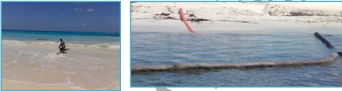
Figura II_ 38. Colocación de tuberías para el transporte de arena.
