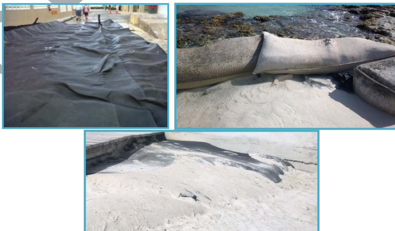
Figura II_ 20. Tubo de geotextil vacío y ejemplo de elemento de geotextil temporal de apoyo
