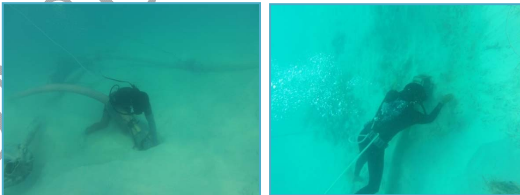
Figura II_ 39. Colocación de tuberías y mangueras para el transporte de arena.
