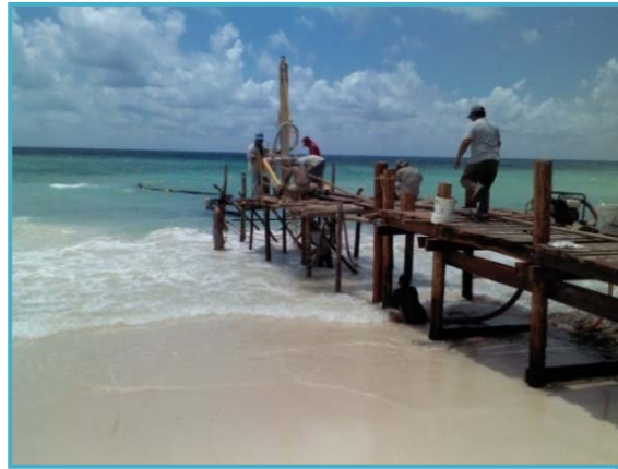
Figura II_ 25. Proceso de perforación y colocación de los pilotes de soporte.
