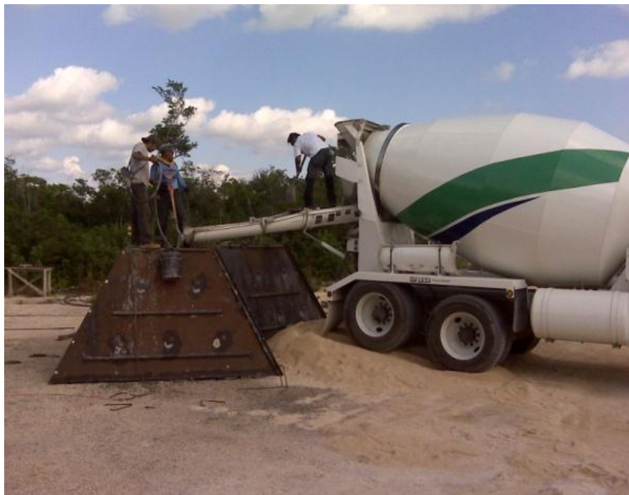
Figura 26. Método constructivo de los AMA®
