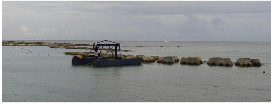
Figura 29. Ejemplo de la balsa pequeña para la colocación final de los AMA®.
