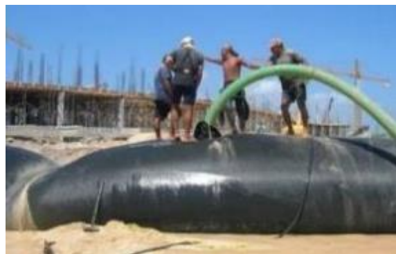
Figura II.10. Ejemplo del extendido, amarre y preparación del geocilindro que conformará la Duna Artificial y del llenado del geocilindro con una tubería flexible de 6 pulgadas.
