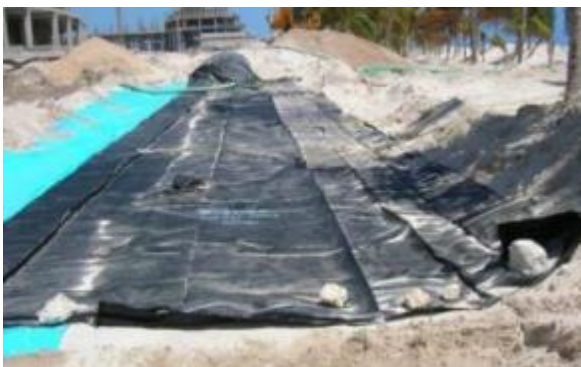
Figura II.10. Ejemplo del extendido, amarre y preparación del geocilindro que conformará la Duna Artificial y del llenado del geocilindro con una tubería flexible de 6 pulgadas.
