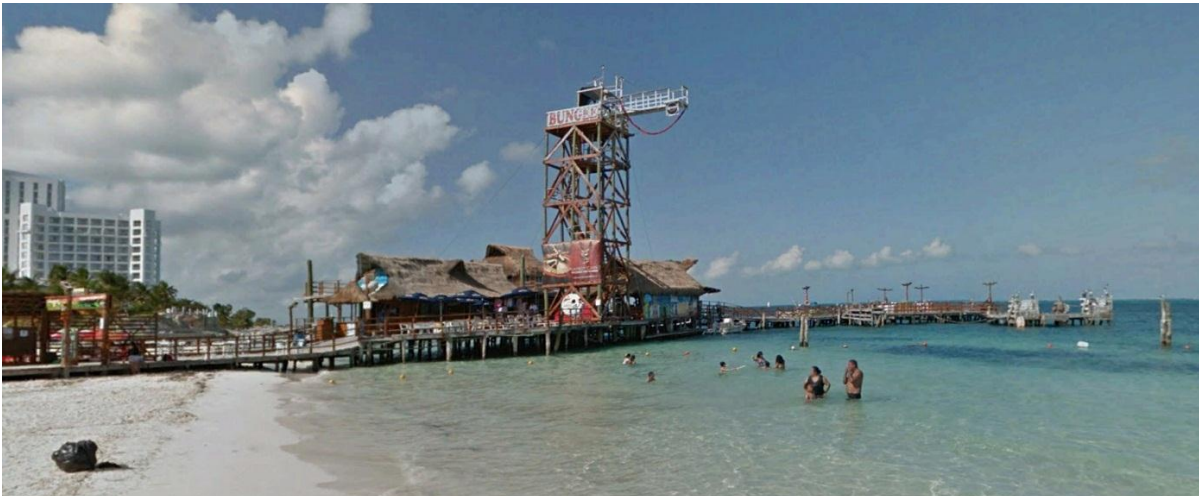
Figura 25. El muelle ubicado en playa tortugas, es un ejemplo de la infraestructura caracterizada en el SA del proyecto.
