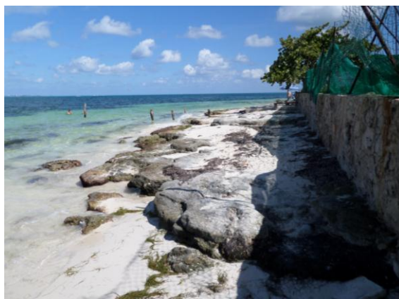
Figura 1. Se muestra el área del arranque se muelle.
