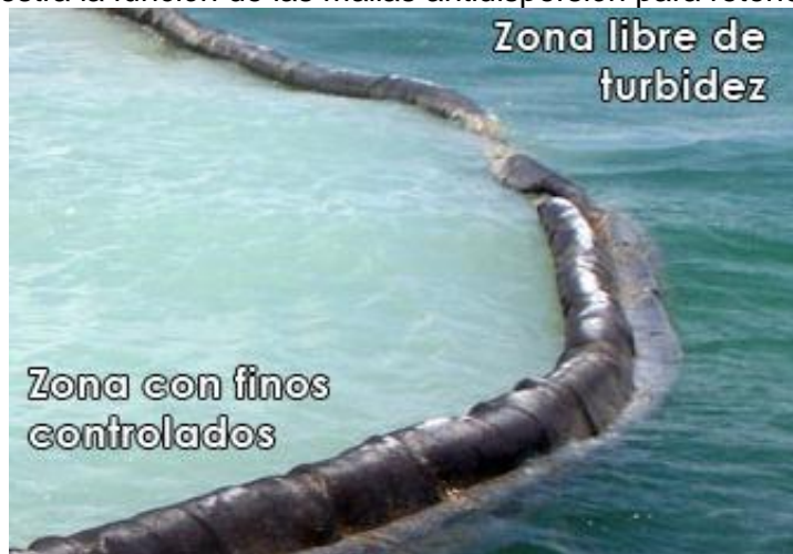
Figura 8. Se muestra a manera de ejemplo el funcionamiento de la malla antidispersión.
