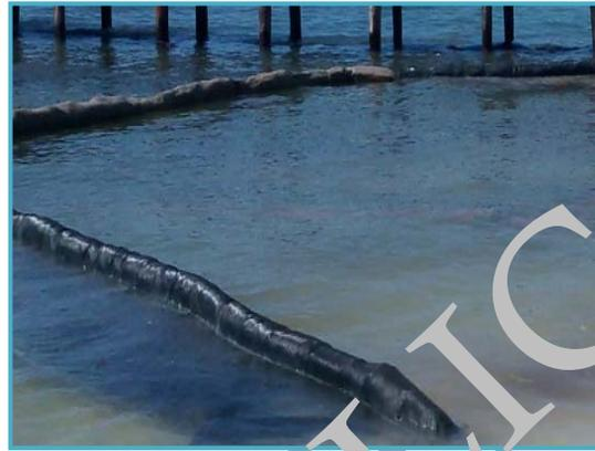
Figura II\_23. Colocación y funcionamiento de malla antidispersión, en proyectos similares.
