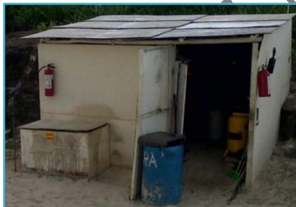
Figura II_24. Ejemplo de bodega provisional.
