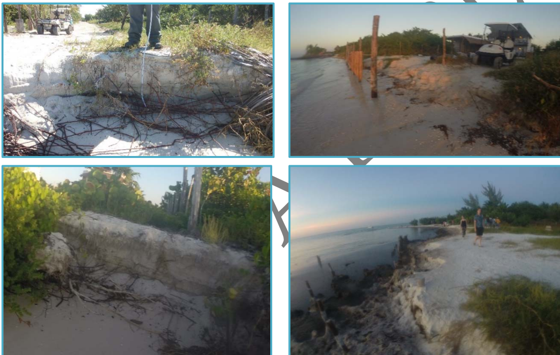
Figura VII_ 2. Erosión en la playa, escarpes y pérdida de la propiedad privada.
