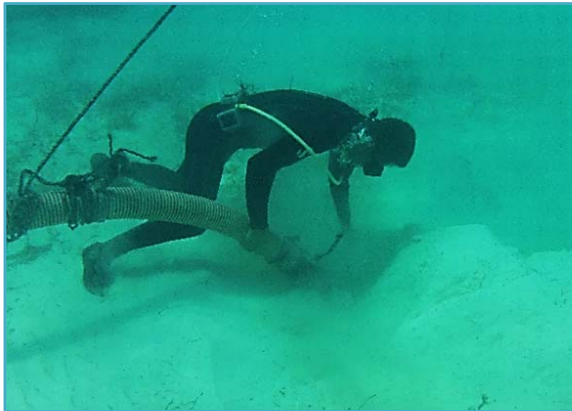
Figura II_ 36. Colocación de tuberías y mangueras para el transporte de arena.
