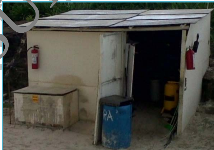
Figura II_ 15. Ejemplo de bodega provisional.
