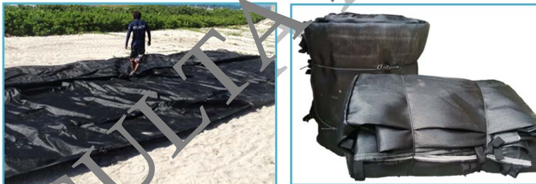
Figura II_28. Tubos de geotextil .
