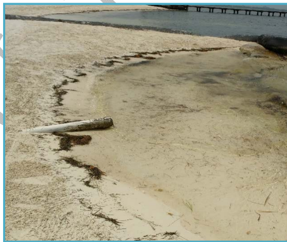
Figura VII_1. Estado actual de la zona del proyecto, Tubería expuesta.
