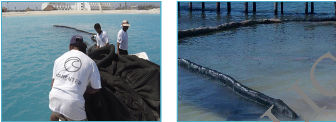
Figura II_20. Colocación y funcionamiento de malla antidispersión, en proyectos similares.
