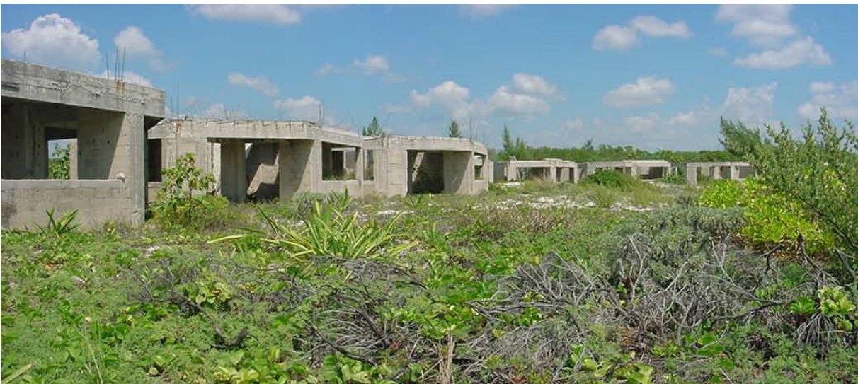
Figura 64. Aspecto de la infraestructura en obra negra que estaba dispuesta sobre el predio, se advierte la presencia de halofitas costeras.
