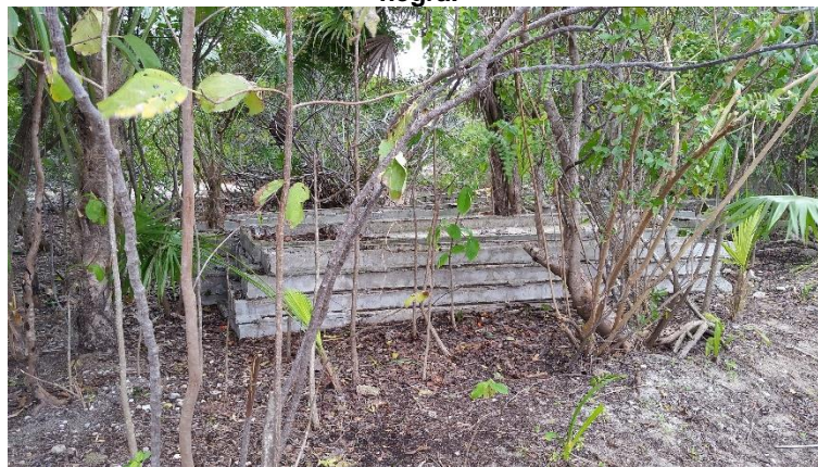
Figura 66. Restos de escombros y obra negra con evidencia de crecimiento de vegetación secundaria.
