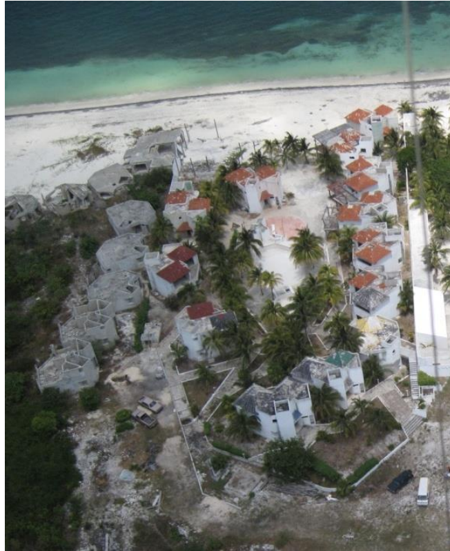
Figura 16. Acercamiento de las obras (ejecutadas entre los años de 1981 y 2000), del proyecto que se encontraban construidas.
