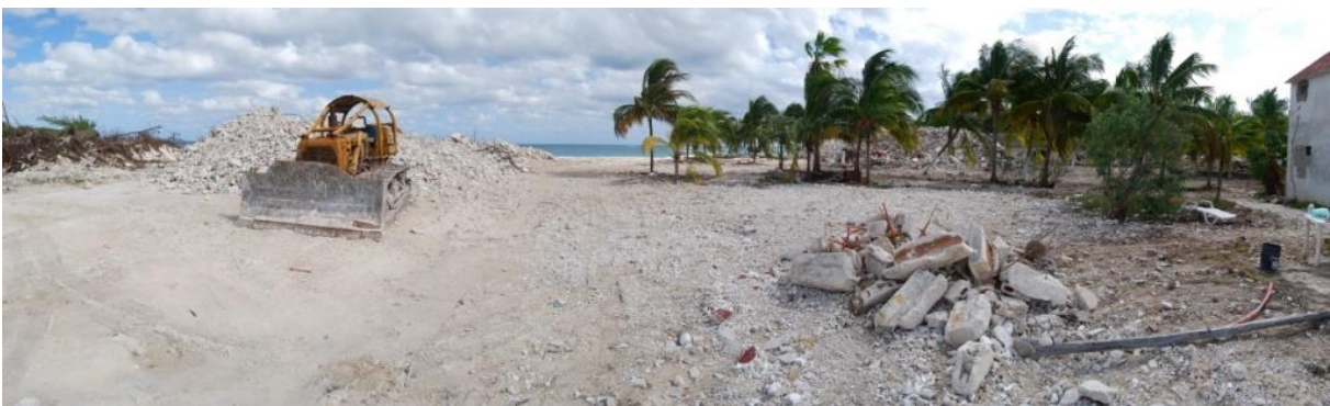
Figura 10. Actividades de demolición del lote de terreno marcado con el número 4-01, manzana 1, supermanzana 31, del predio denominado "Petempich" ubicado en la localidad de Puerto Morelos, resultado de la demolición efectuada conforme lo solicitado en el oficio 04/SGA/105/2004.
