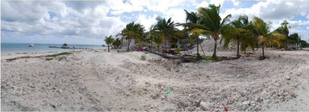
Figura 8. Aspecto de la playa en la zona sur del lote de terreno marcado con el número 4-01, manzana 1, supermanzana 31, del predio denominado "Petempich" ubicado en la localidad de Puerto Morelos, resultado de la demolición efectuada conforme lo solicitado en el oficio 04/SGA/105/2004.
