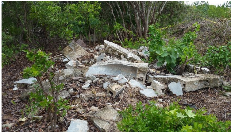
Figura 68. Escombros derivados de las obras abandonadas, se advierte la cobertura vegetal circundante.
