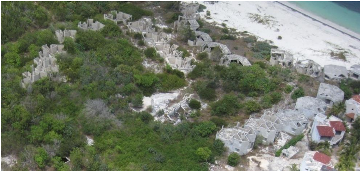
Figura 17. Acercamiento que muestra las estructuras (ejecutadas entre los años de 1981 y 2000) en obra negra que se localizaban en la parte norte del predio.
