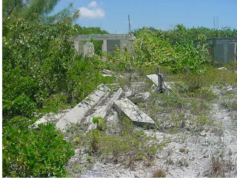
Figura 63. Aspecto de las obras abandonadas y el crecimiento de vegetación secundaria.
