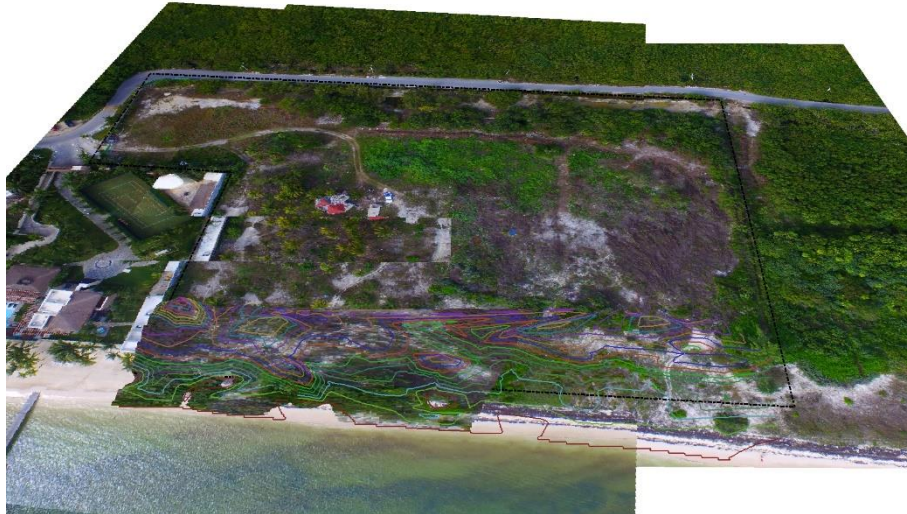
Figura 55. Curvas de nivel de la geoforma litoral, establecidas a través del levantamiento topográfico.
