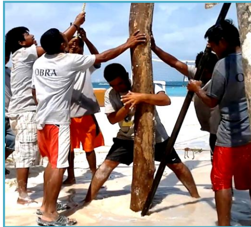
Figura II_ 15. Proceso de chifoneo y colocación de pilotes de soporte.
