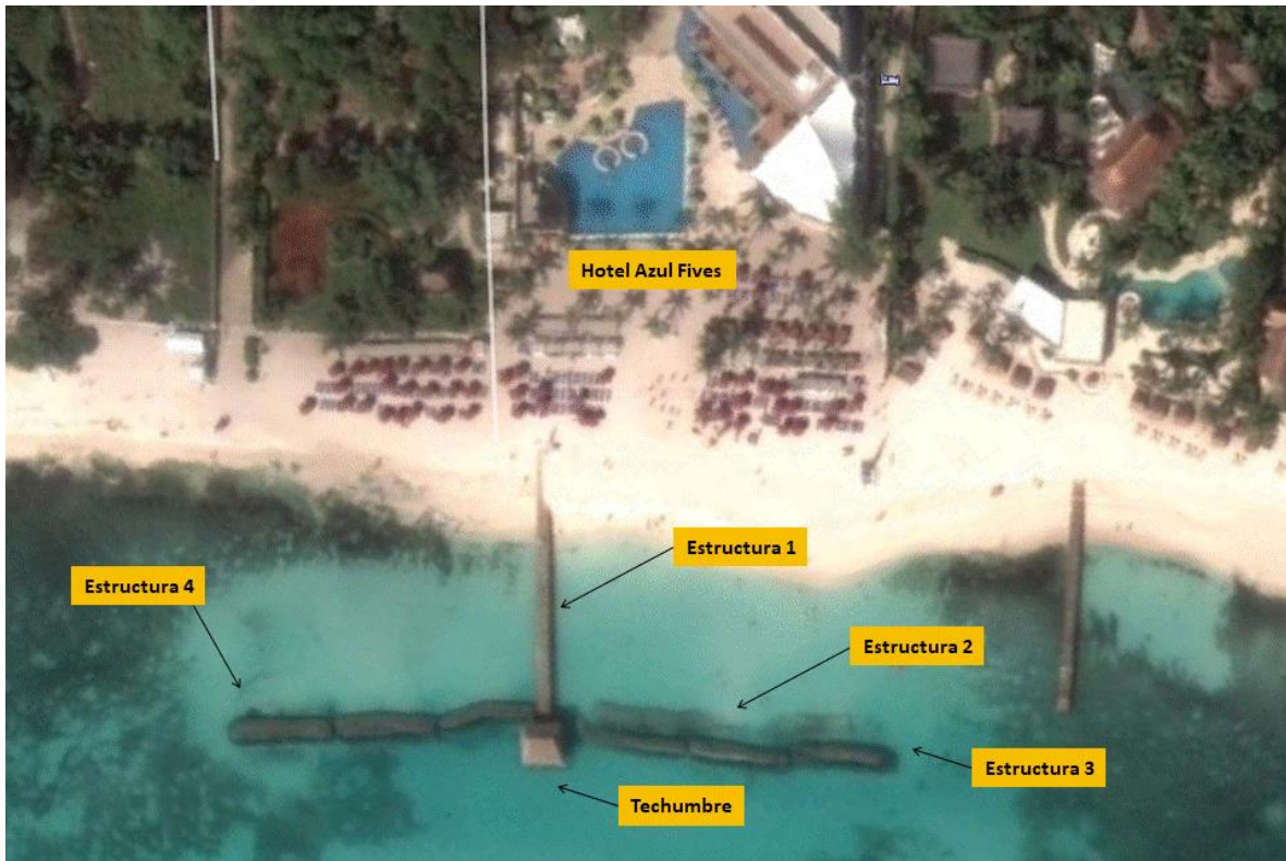
Figura II.1. Vista general del proyecto, en la cual se puede apreciar la colocación de las estructuras.
