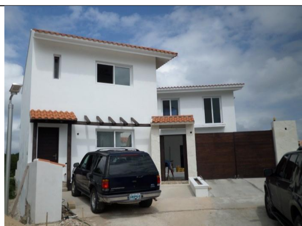
Lotes turísticos residenciales más cercanos al predio del proyecto, y separados de este por el canal de la marina.
