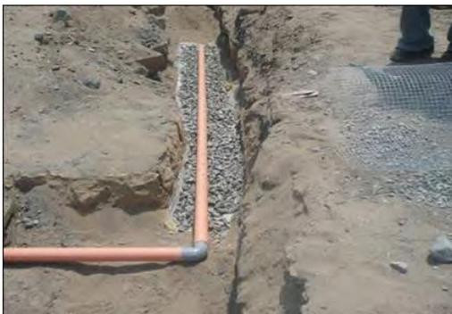
La capa de piedra por debajo de la tubería debe de tener un espesor de 0.15cm.
