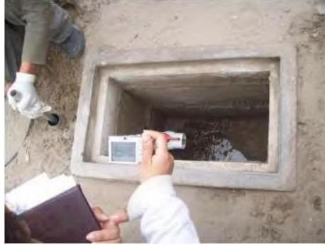
**Figura 2.26.-** Abrir válvula de lodos del registro.
