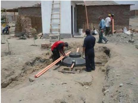
Excavar las zanjas del ancho considerado, la profundidad será de acuerdo a la cota de salida de la tubería de agua tratada (2") del biodigestor.
