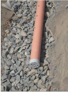
La tubería de 2" deberá estar perforada con orificios menores a 1/2" de diámetro (siempre menor al de la piedra).
