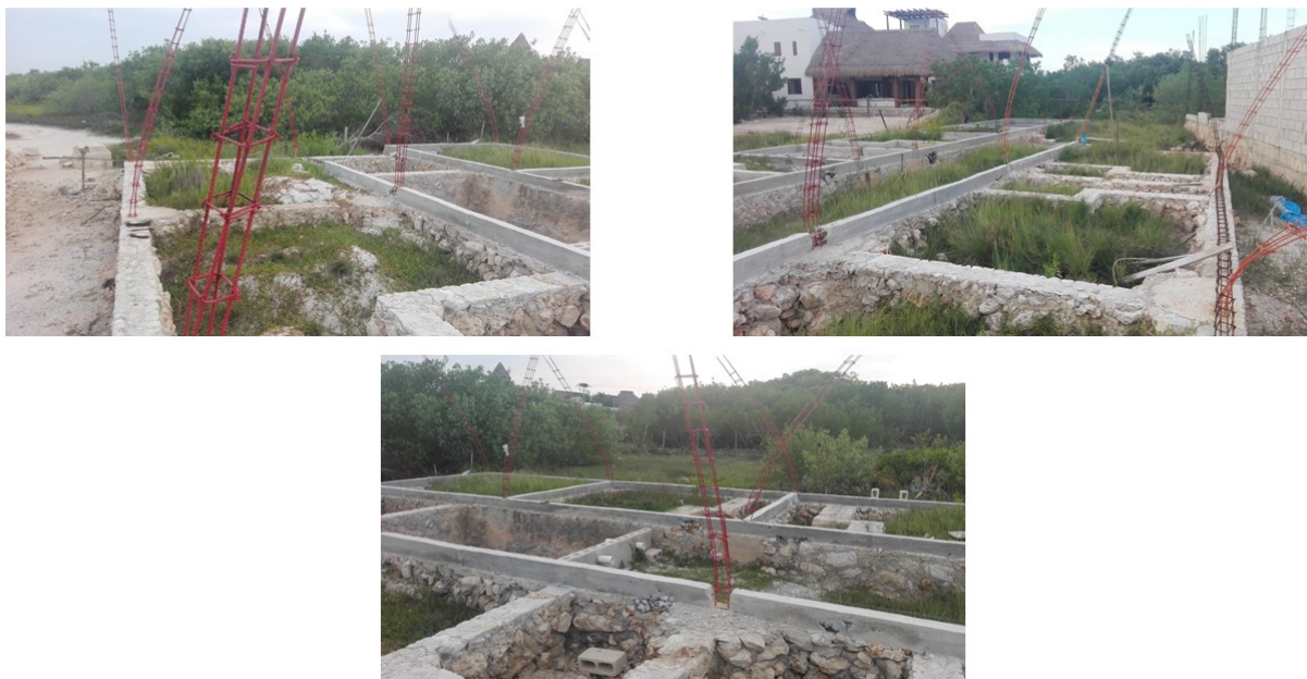
Figura 5 obras existentes en el predio donde se proyecta la casa habitación
