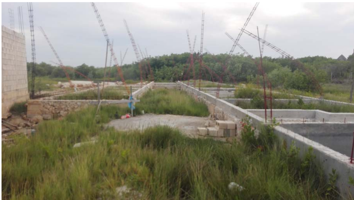
Figura 1 obras actuales realizadas en el predio destinado para el proyecto Casa Arroyo
