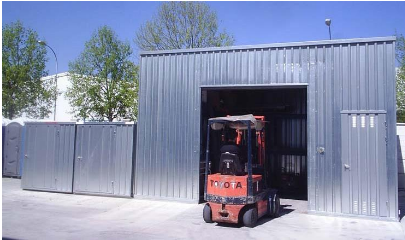
Figura 6.3. Ejemplos de almacenes provisionales donde se resguarda material de obra.
