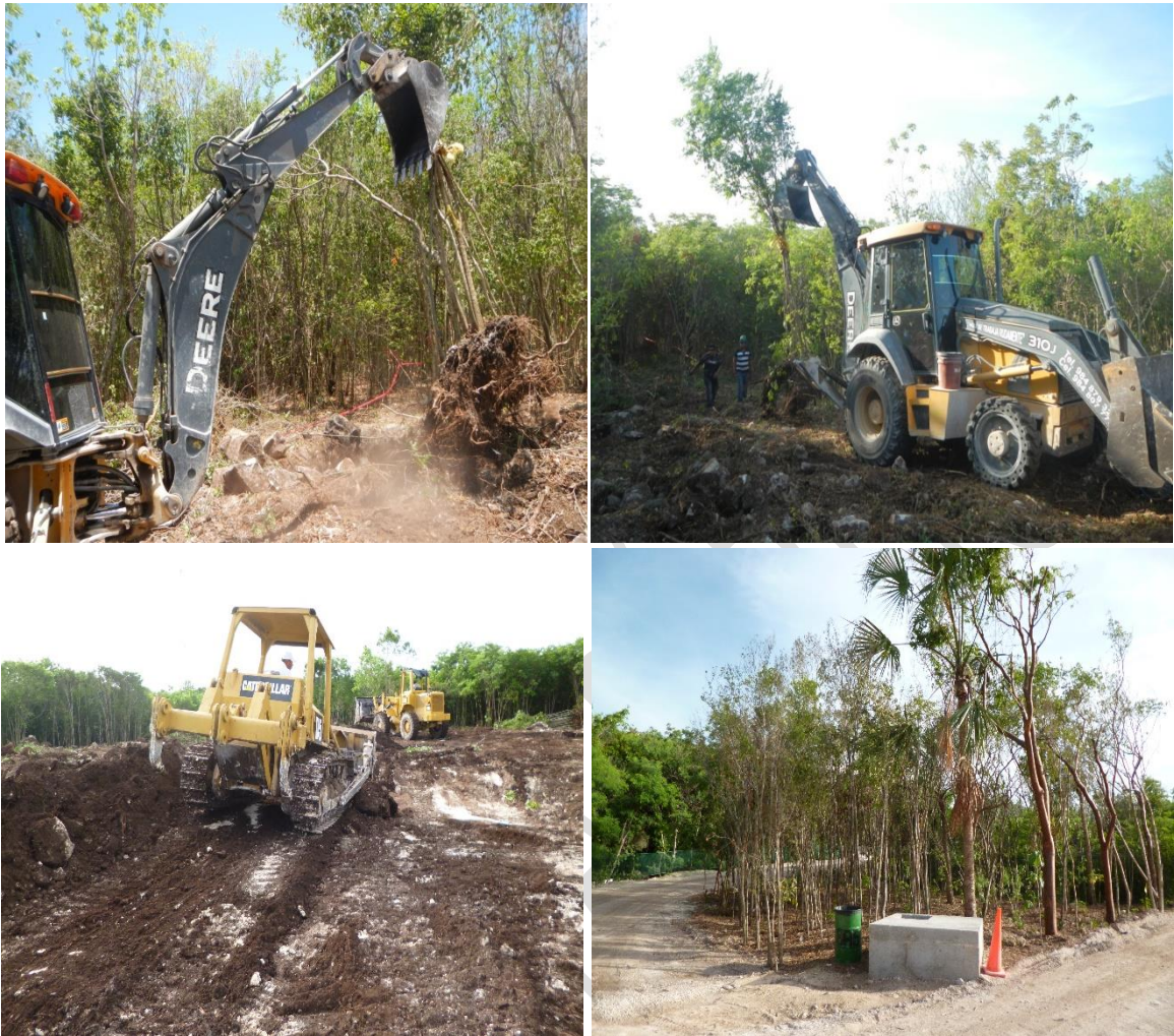
Actividades de desmonte
