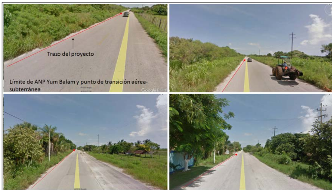
Figura II.2.3-2. Inicio del trazo subterráneo en el límite del ANP y punto de transición. A la orilla de la carretera se presenta vegetación ruderal herbácea.
