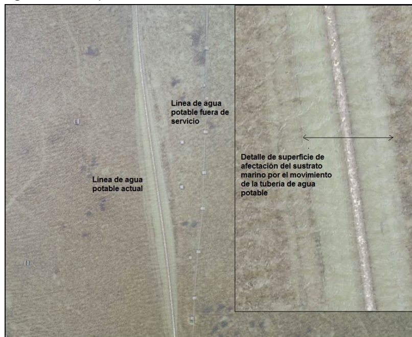
Figura VII.3-1. Detalle de un tramo de la tubería que surte agua potable a Holbox.
