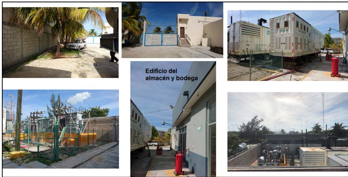
Figura II.2.5.2-1. Instalaciones actuales de la CD Holbox.
