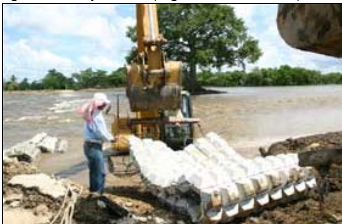
Figura II.2.5.1.2.1-3. Ejemplo de colocación de tapete de concreto.
