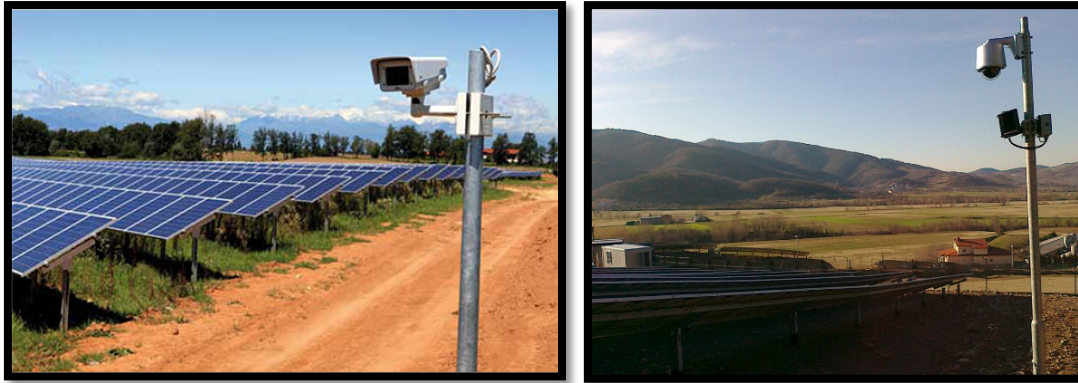
Figura II.12. Ejemplificación del sistema de monitoreo en un parque solar 3 .
