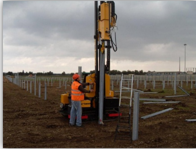
Fotografía II.2. Ejemplificación de maquinaria utilizada para el hincado de perfiles en un parque solar 1 .
