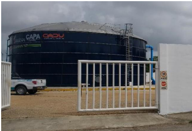
Tanque de Agua potable "Cárcamo 9"
