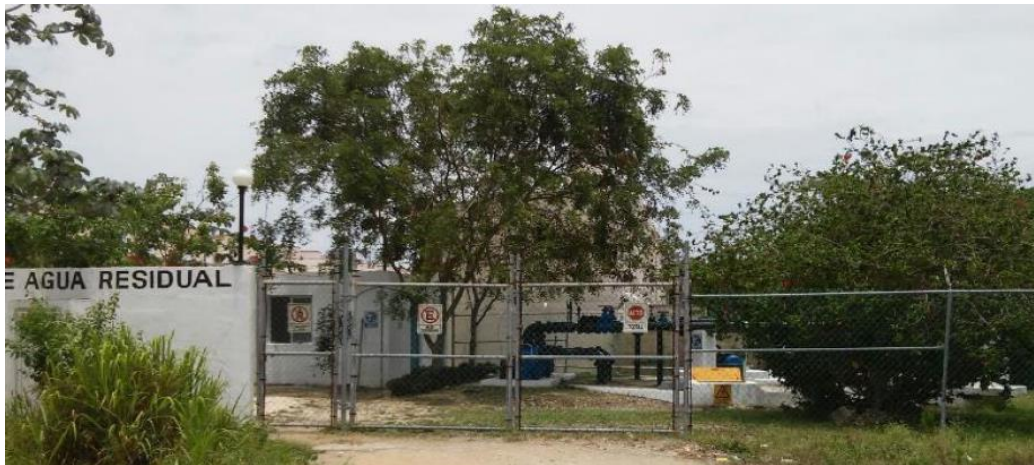
Cárcamo Puerto Aventuras
