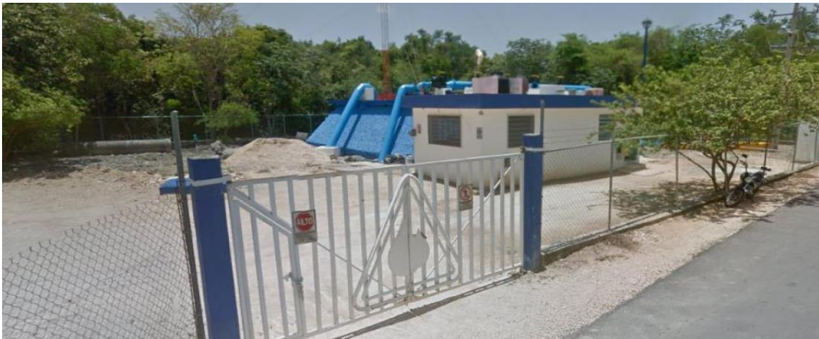
Tanque de Agua potable "Cárcamo Intermedio"
