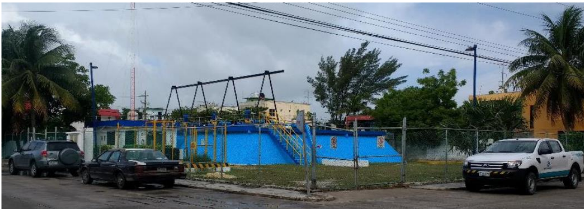
Tanque de Agua potable "Cárcamo 3"
