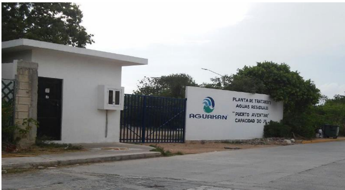
Planta de tratamiento de aguas residuales, Puerto Aventuras.
