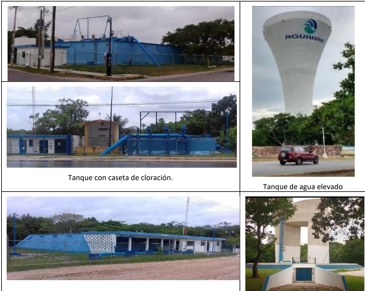
Figura II. 9. Tanques de agua potable.
