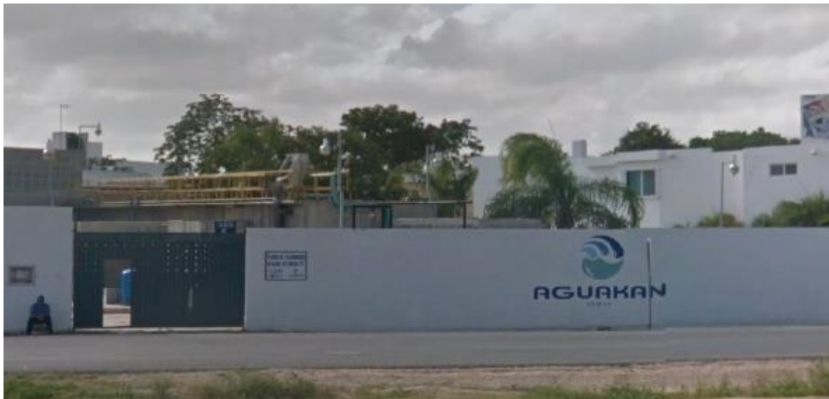
Planta de tratamiento de aguas residuales "Isla Azul"
