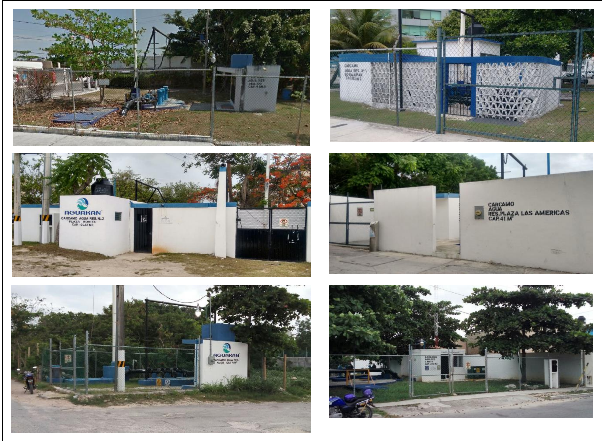
Figura II. 12. Cárcamos de aguas residuales.
