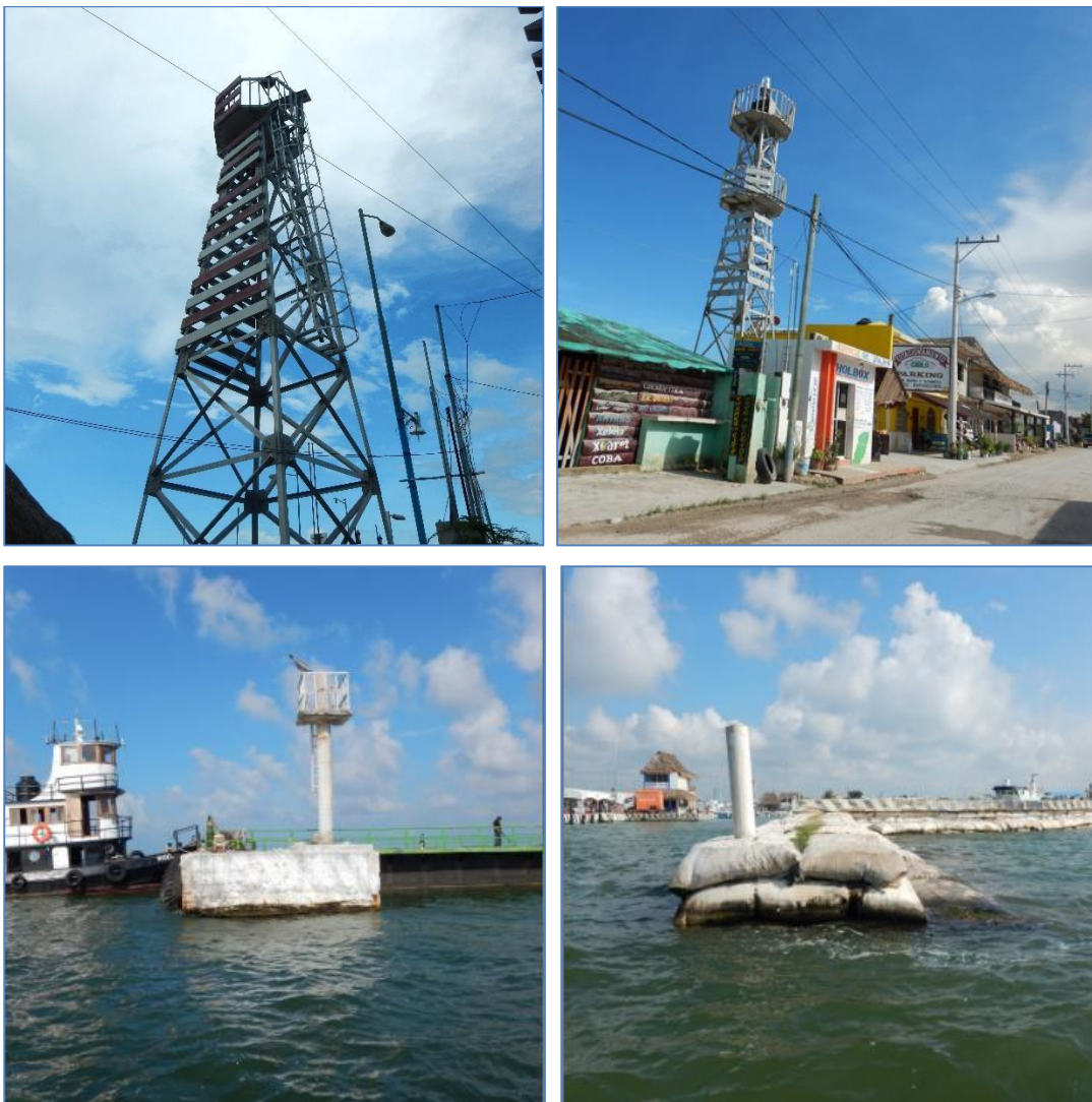
Figura VIII. 25. Fotografías de las balizas de enfilación frontal y posterior, así como de situación.
