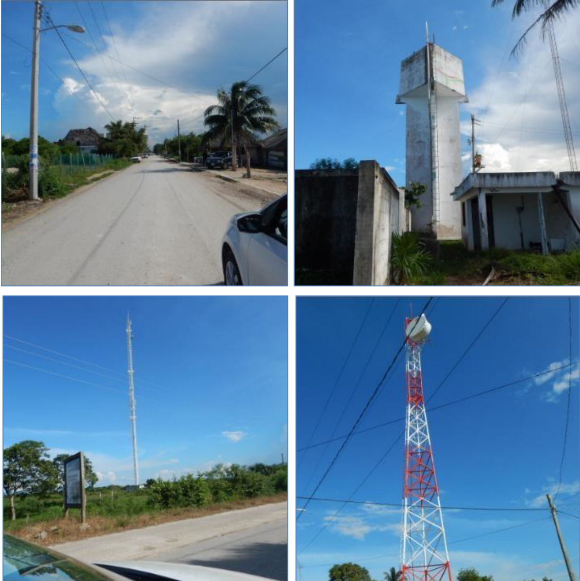
Figura VIII 1. Servicios de electricidad, agua potable y telecomunicaciones en la localidad de Chiquilá.
