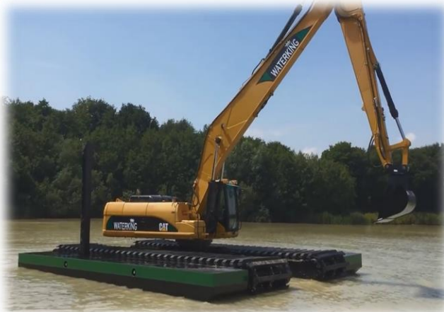
Fotografía II. 4. Excavadora anfibia con bomba de dragado.
