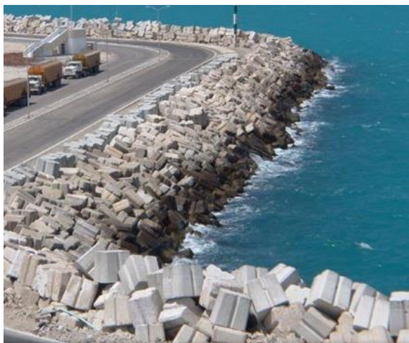
Figura 14a. Se muestra el tipo de cubos ranurados que se utilizarán para los arrecifes. En el caso de Grand Velas no serán visibles ya que estarán a nivel medio del mar.
