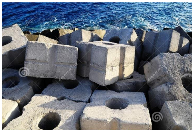
Figura 14a. Se muestra el tipo de cubos ranurados que se utilizarán para los arrecifes. En el caso de Grand Velas no serán visibles ya que estarán a nivel medio del mar.
