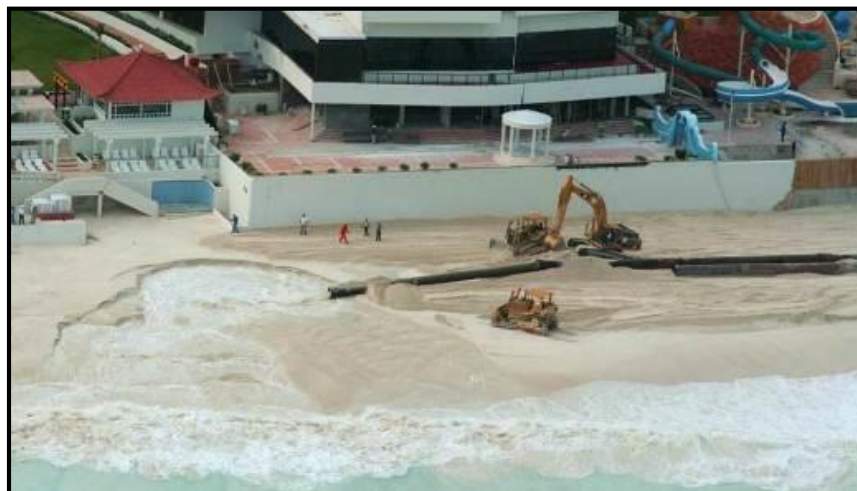
Figura 41b. Descarga de mezcla agua-arena en la playa con tubería rígida y maquinaria de apoyo para acomodar la arena vertida (Foto de relleno de arena en Cancún en 2006).
