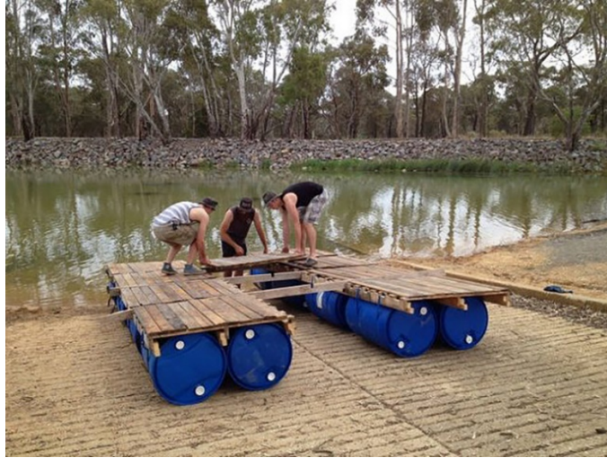
Figura 2.12.- Ejemplificación de construcción de balsa para el transporte de los componentes que integraran la pieza de arrecife artificial.
